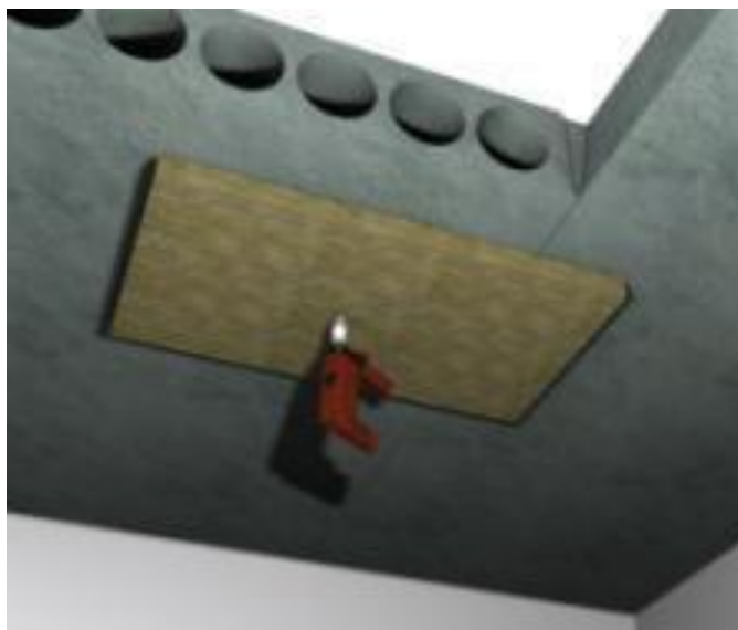
Рис.3. Сверление железобетонной конструкции
