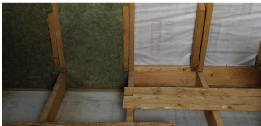
Рис. 2. Подготовленная система для дальнейшего монтажа теплоизоляции
