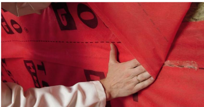
Рис. 6. Проклейка стыков пароизоляционной пленки
