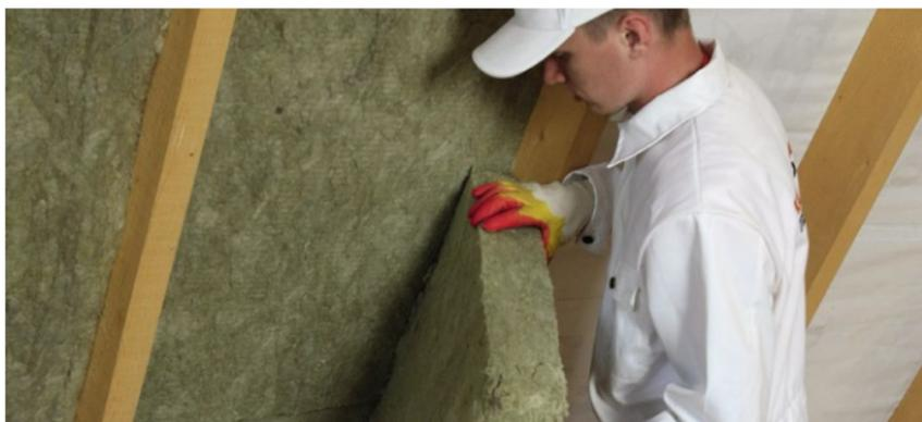
Рис. 3. Монтаж теплоизоляции враспор между стропилами
