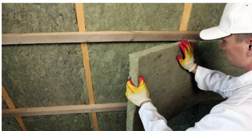
Рис. 4. Укладка второго слоя теплоизоляции
