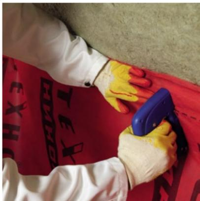
Рис. 5. Укладка и фиксация пароизоляционной пленки
