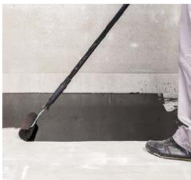
Праймер наносится на основание при помощи мехового валика.
