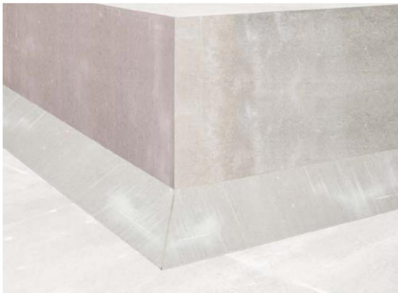
Поверхность основания должна быть ровной и гладкой. При проверке ровности просветы под трехметровой рейкой должны быть только плавного очертания и не более одного на 1 м. Максимальная глубина просвета не должна превышать 5 мм.
