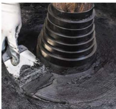
Поверх юбки уплотнителя нанесите слой **Мастики № 71 ТЕХНИКОЛЬ** герметизирующей.
