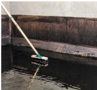
Нанесите первый слой мастики при помощи кисти, шпателя, либо наливом с разравниванием. Нанесение мастики следует начинать с пониженного участка (водоприемная воронка, карниз).
