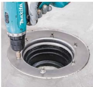
Вставляем фланец и закрепляем его.
