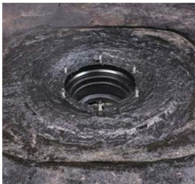
Поверх фланца водоприемной воронки наносим **Мастику № 71 ТЕХНОНИКОЛЬ** герметизирующую.
