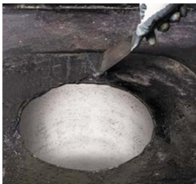
Поверх слоя усиления равномерно наносим **Мастику № 71 ТЕХНОНИКОЛЬ** герметизирующую.
