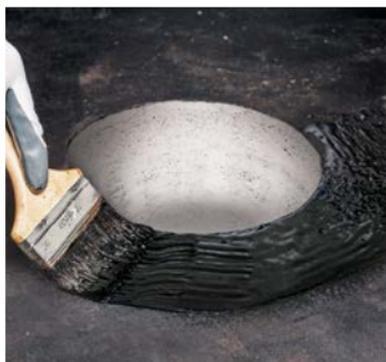
Наносим слой **Мастики № 21 ТЕХНОНИКОЛЬ** в области местного понижения водоприемной воронки.
