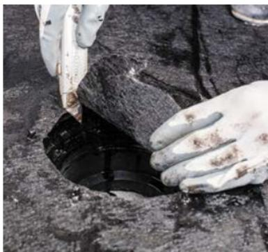
Прорезаем полученный гидроизоляционный ковер по отверстию трубы водоприемной воронки.
