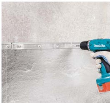
Для фиксации края кровельного ковра на вертикальной поверхности закрепите краевую алюминиевую рейку при помощи остроконечных саморезов ТЕХНОНИКОЛЬ EDS-S 4,8 с полиамидной гильзой с шагом 200 мм.
