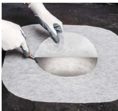
Вырезаем круглое отверстие под трубу водоприемной воронки.
