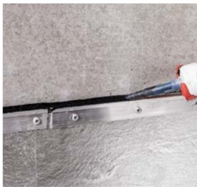
Зазор между стеной и рейкой необходимо заполнить **Мастикой № 71 ТЕХНОНИКОЛЬ** герметизирующей.
