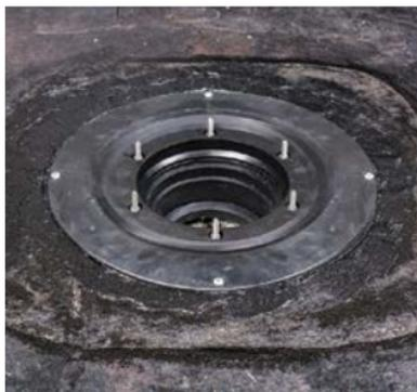
Закрепляем водоприемную воронку к основанию, используя минимум 4 крепежных элемента. В качестве крепежных элементов применяйте остроконечные саморезы **ТЕХНОНИКОЛЬ EDS-S 4,8** с полиамидной гильзой.
