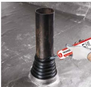
Между трубой и уплотнителем нанесите **Мастику № 71 ТЕХНОНИКОЛЬ** герметизирующую.
