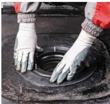
Устанавливаем воронку и вдавливаем юбку воронки в мастику. Вытек мастики из-под юбки воронки обеспечит надежную герметичность соединения.
