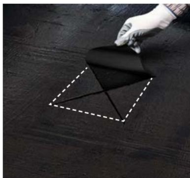
Затем отгибают концы материала, наносят на основание **Мастику № 71 ТЕХНОНИКОЛЬ** герметизирующую и приклеивают отогнутые края, прикапывая их силиконовым роликом.
