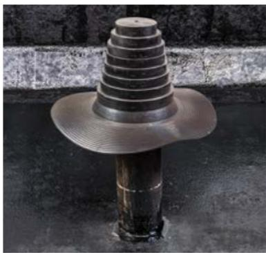
Наденьте уплотнитель на трубу и определите нужный диаметр.
