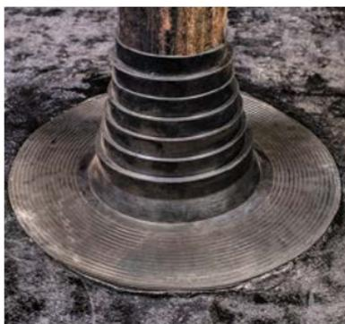
Установите уплотнитель, вдавив его в мастику. Равномерный вытек мастики из-под юбки уплотнителя обеспечит надежную герметизацию соединения.
