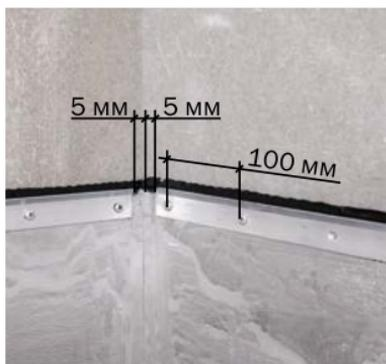
Краевую рейку в местах внутренних и внешних углов необходимо разрезать, оставив 5 мм от рейки до края стены. Саморезы в местах углов необходимо располагать в 100 мм от угла, далее — с обычным шагом в 200 мм.
