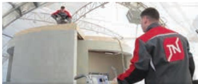
клиновидной теплоизоляции PIR Slope. В качестве кровельного ковра применена ПВХ-мембрана: прочный и технологичный в монтаже материал. Полотна мембраны свариваются горячим воздухом с помощью специального оборудования.
