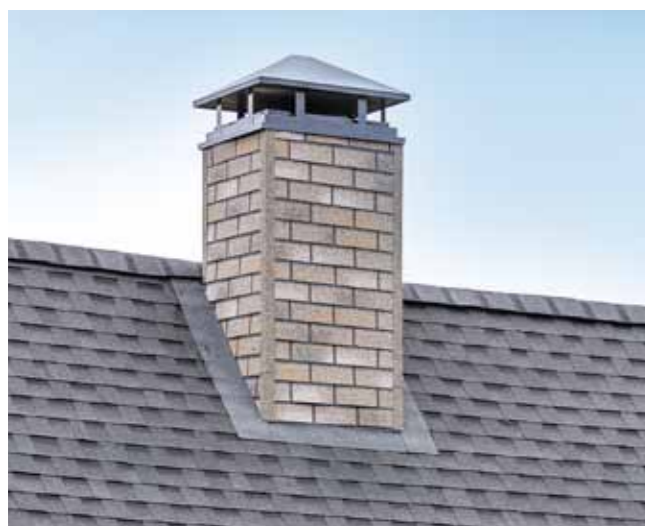
Рис. 3. Оформление печной трубы
