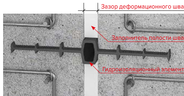
Рис. 3.3. Конструкция деформационного шва
