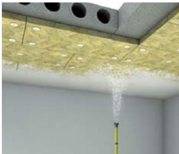
Рис. 7. Нанесение декоративного покрытия окрасочным оборудованием
