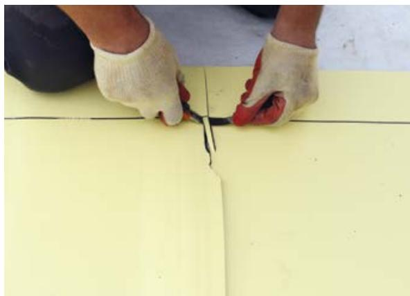
Свободный край поперечного шва необходимо удалить с обеих сторон полотна. После этого нужно снять фаску. Для выполнения сварного шва на местах поперечных стыков полотен следует устранить технологический отступ посредством снятия фаски под сам шов.
