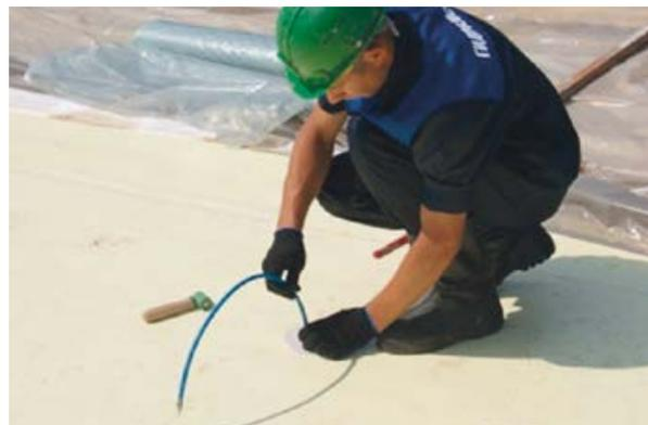
В случае монтажа базовой и расширенных модификаций системы Тип 2 А-2 и Тип 2 А-3 следует предусматривать применение инъекционных штуцеров из ПВХ, а для расширенной модификации системы Тип 2 А-1 – инъекционных штуцеров из ТПО. Для правильной работы штуцеров их приварку к полотну мембраны необходимо производить точечным методом так, чтобы «юбка» штуцера не имела сплошной приварки к гидроизоляционному покрытию.
