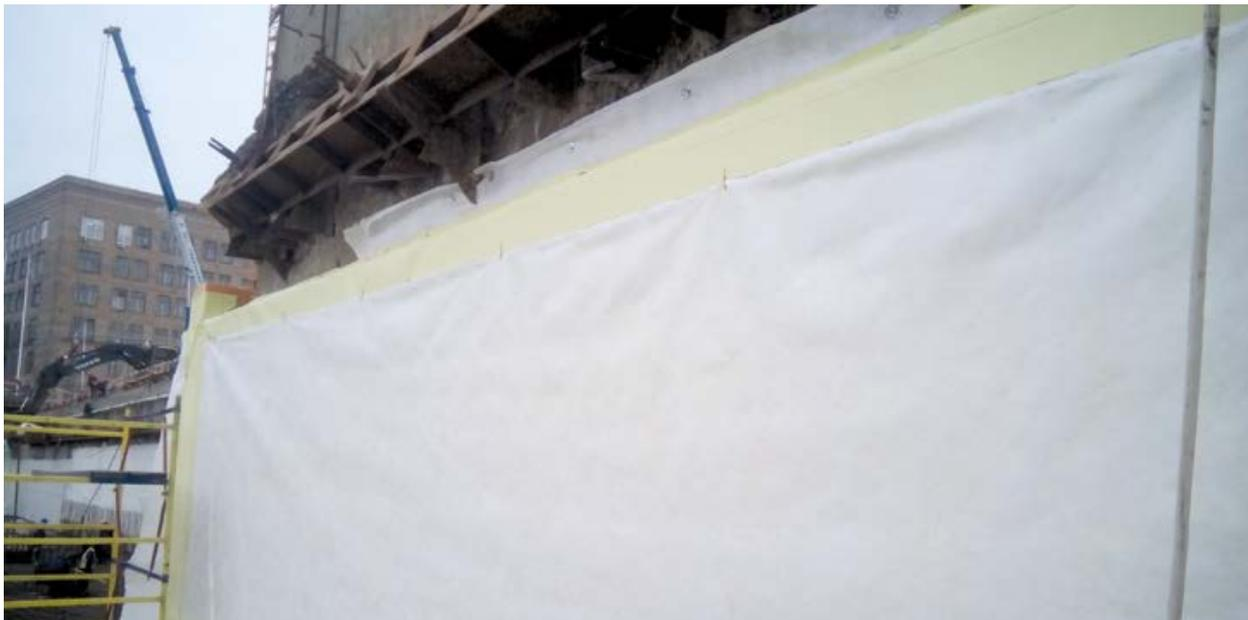
**2.2.9** Механическое крепление к бетонному основанию материалов, применяемых для защиты гидроизоляционного покрытия, сквозь их поверхность не допускается.
