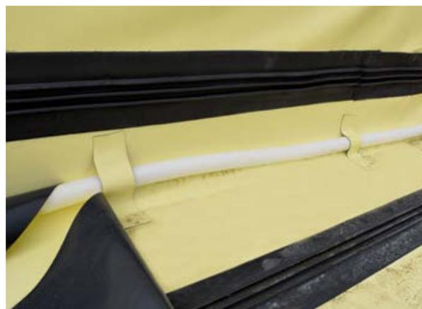
**2.1.15** По окончании монтажа гидроизоляционного покрытия фундаментной плиты оно должно быть защищено от повреждений в процессе общестроительных работ. В зависимости от модификации изоляционной системы для защиты полимерной мембраны могут применяться следующие материалы:
