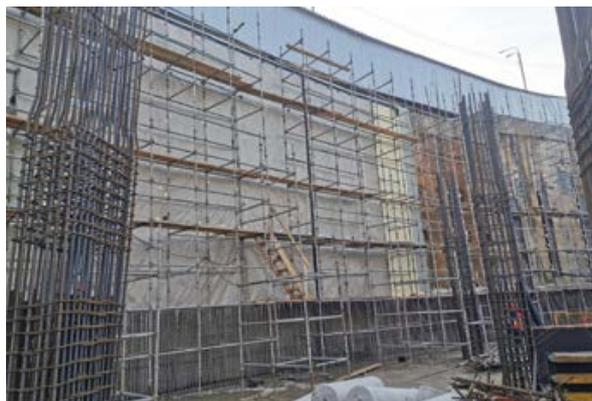
**3.2.1** По окончании монтажа гидроизоляционного покрытия, сварки нахлестов и проверки качества сварки следует выполнить монтаж защитных слоев. В зависимости от модификации монтируемой системы для защиты гидроизоляционного покрытия могут применяться следующие материалы:
