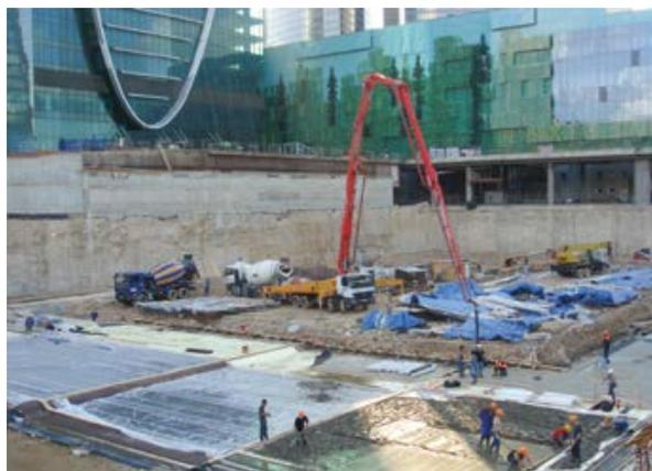
**2.2** Второй этап работ по монтажу изоляционной системы (гидроизоляция стен фундамента) должен начинаться после окончания этапа монолитных работ по бетонированию стеновых ограждающих конструкций.
