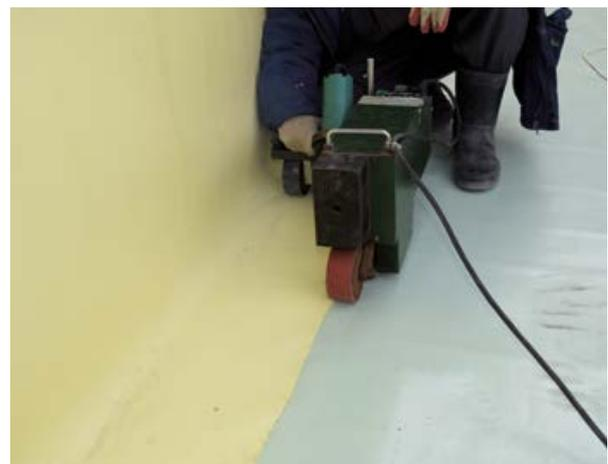
Данный способ приваривания требуется применять также для соединения всех последующих карт-участков.
