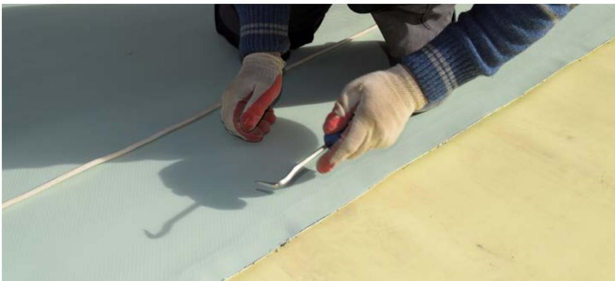
**8.1.12** Непосредственно после формирования секции между двумя слоями гидроизоляционных мембран рекомендуется выполнить проверку методом вакуумирования в соответствии с разделом 10 настоящего руководства.
