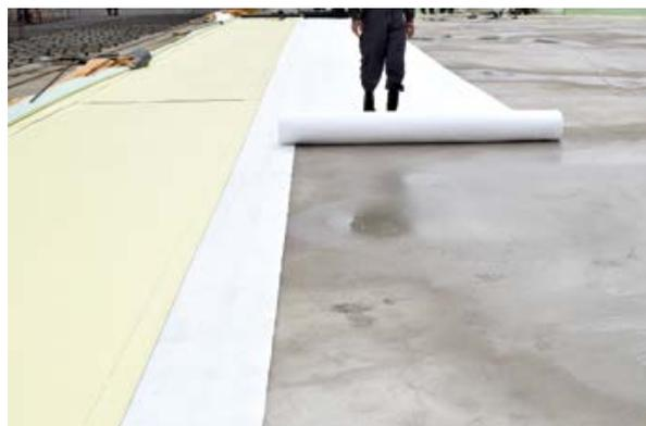
**2.1.6** «Подстилающий» слой из геотекстиля, применяемый для подготовки бетонного основания, не может быть заменен другими элементами системы (независимо от ее модификации).
