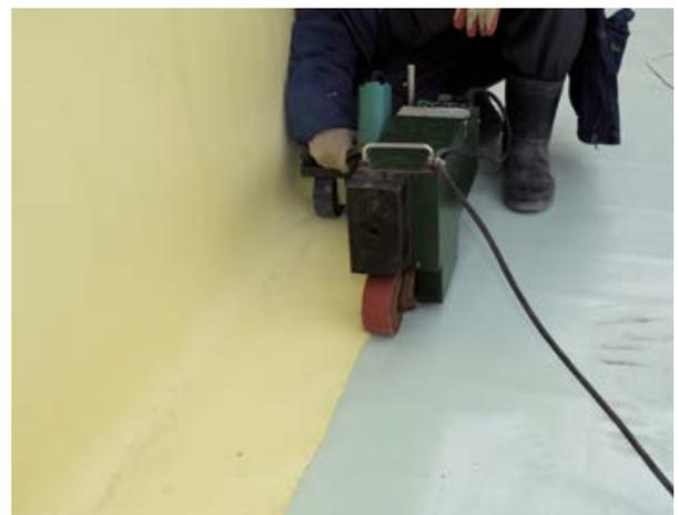
Данный способ приваривания требуется применять также для соединения всех последующих карт-участков.
