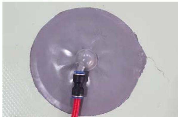
**10.11** К остальным штуцерам крепятся трубки, которые соединяются с гребенкой, установленной на вакуумном насосе. Для подключения инъекционных трубок к гребенке применяются специальные переходники «резьба-елочка».
