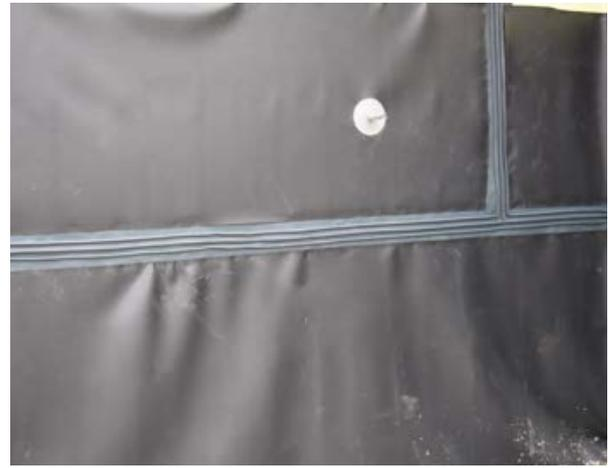
**6.1.9** Вне зависимости от модификации монтируемой изоляционной системы все ее компоненты, включая геотекстиль, полимерную пленку и защитные мембраны под фундаментной плитой, должны быть защищены от повреждений в ходе монтажа арматурного каркаса. Для защиты гидроизоляционного покрытия следует предусматривать слой из мелкозернистого бетона (класс не ниже В25; толщина 4-10 см) или цементно-песчаного раствора (класс не ниже М150; толщина 40-50 мм).
