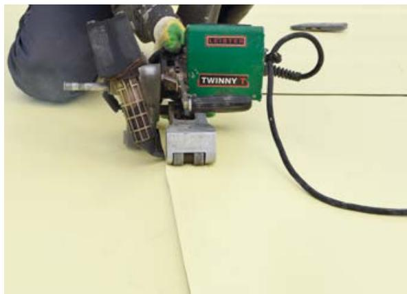
На Т-образных соединениях, где продольный шов проходит через поперечный, необходимо срезать свободный край поперечного шва. Длина срезаемого свободного края должна быть равна ширине продольного нахлеста, т.е. 100-120 мм.
