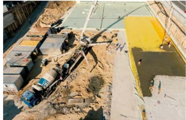
**8.1.16** Устройство арматурного каркаса фундаментной плиты. После монтажа арматурного каркаса через него пропускаются трубы, соединяющие инъекционные штуцеры с инъекционными коробками. Производится бетонирование фундаментной плиты.
