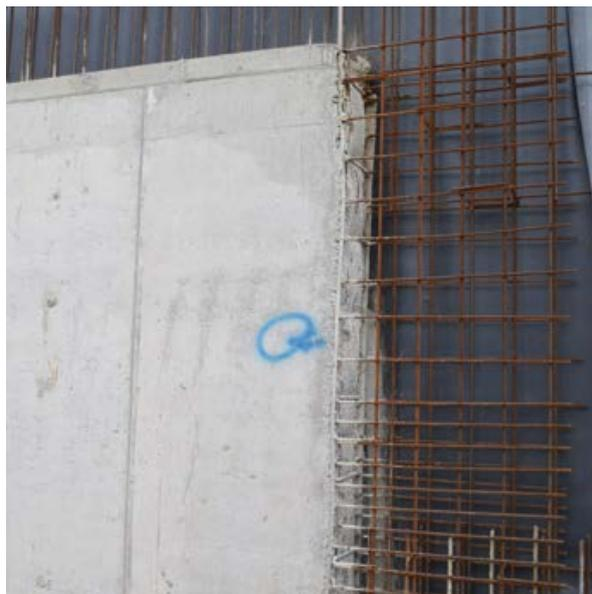
**6.2.6** Монтаж арматурного каркаса захватки бетонирования и укладка бетонной смеси. Особое внимание следует уделить качеству осуществления виброуплотнения в зоне гидрошпонок.
