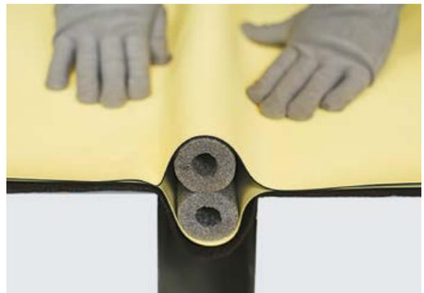
При монтаже бетонной подготовки в местах будущих деформационных швов для формирования компенсационной петли необходимо заранее установить закладной элемент на необходимую глубину (ширина в соответствии с проектом). Если в процессе монтажа бетонной подготовки закладной элемент не устанавливался, то сформировать штробу можно посредством штрабления бетонной подготовки с последующей доработкой поверхности шлифовальным оборудованием и цементным раствором.
