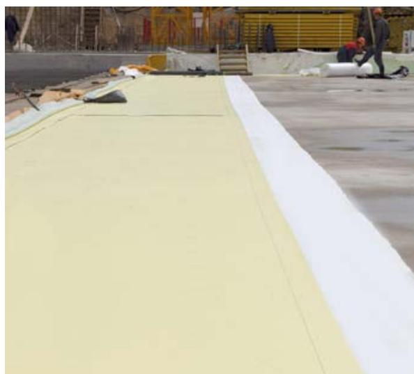
**2.1.8** В случае применения гидроизоляционного покрытия марок LOGICBASE V-SL и LOGICBASE P-SL для монтажа базовой модификации системы ТН-ФУНДАМЕНТ Дренаж Барьер Тип 1 мембраны должны быть смонтированы с ориентацией лицевой поверхности (желтого для V-SL и светло-бежевого для P-SL цвета) к последующему бетонированию фундаментной плиты. При монтаже модификаций системы Тип 1 А-2 и Тип 1 А-3 требования по ориентации лицевой поверхности не вводятся (лицевая сторона ориентирована во внутрь рулона).
