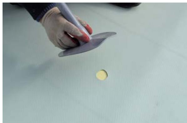
Штуцеры приваривают к поверхности мембраны второго гидроизоляционного слоя сплошным швом по окружности фланца с предварительной прорезкой отверстия в этой мембране по границе проходного канала штуцера. Таким способом обеспечивается доступ к пазухе между двумя слоями гидроизоляции отдельной секции.
