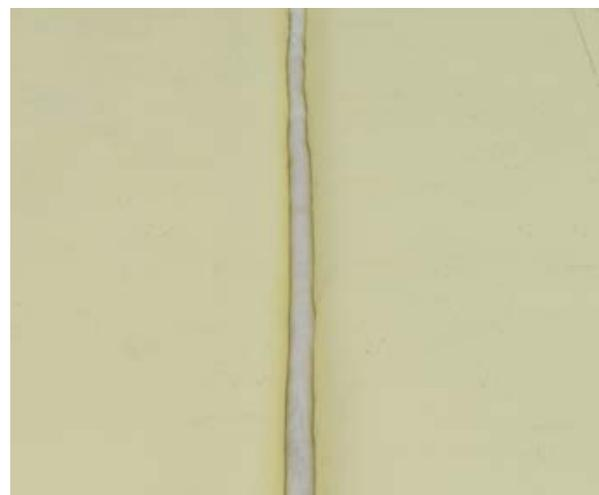
**2.1.10** По мере раскатки рулонов полотна выстилаются с формированием нахлеста вновь укладываемого полотна на уже размещенное. Минимальный размер нахлеста должен составлять 100 мм.
