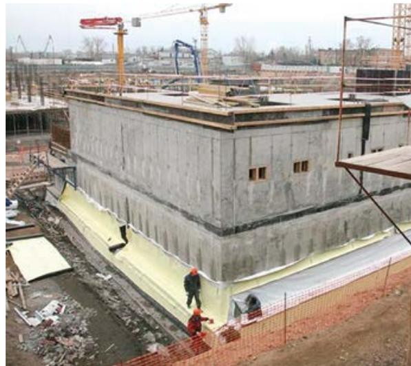
**5.2.6** После монтажа гидроизоляционных лент LOGICBASE на ограниченные гидроизоляционными лентами секции бетонных поверхностей стен и перекрытия (при наличии) проводится укладка полотна геотекстиля с нахлестом 100 мм (без нахлеста на гидроизоляционные ленты). Крепление геотекстиля на вертикальной поверхности стены осуществляется в соответствии с п. 2.2.1-2.2.2 настоящего руководства, а на горизонтальных секциях покрытия геотекстиль укладывается свободно (без крепления).
