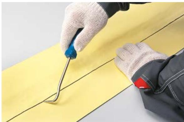
Инструментальный контроль качества шва осуществляется следующим образом:
