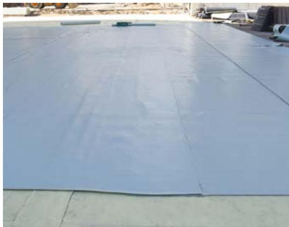
**8.1.6** Монтаж второго слоя гидроизоляционного покрытия следует выполнять в соответствии с разработанной схемой секционирования. При этом раскладку мембран и их сварку между собой осуществляют теми же методами, которые использовались для устройства первого слоя (т.е. с применением автоматического сварочного оборудования, создающего двойной шов с воздушным проверочным каналом).
