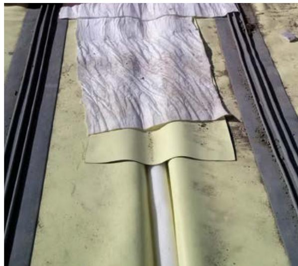
Продольные и поперечные нахлесты, образованные в процессе формирования смежных полотен, должны быть сварены горячим воздухом с применением автоматического оборудования, а их герметичность обязательно проверяется при помощи сжатого воздуха.
