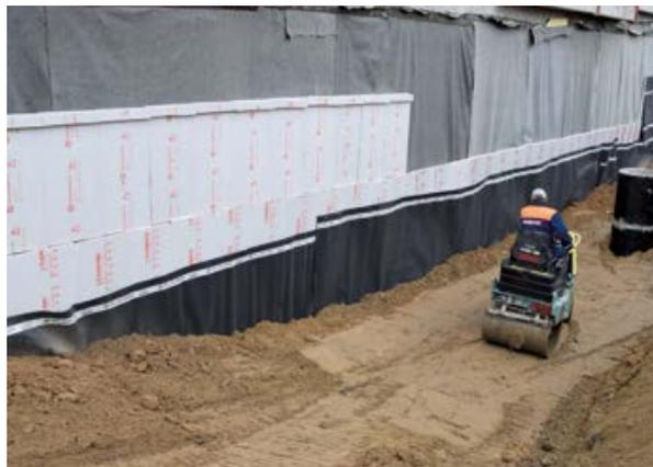
Во время утепления стен полотна из профилированных мембран крепятся к уже установленному слою утеплителя при помощи полимерного винта с широкой резьбой (например, винт XPS R16).
