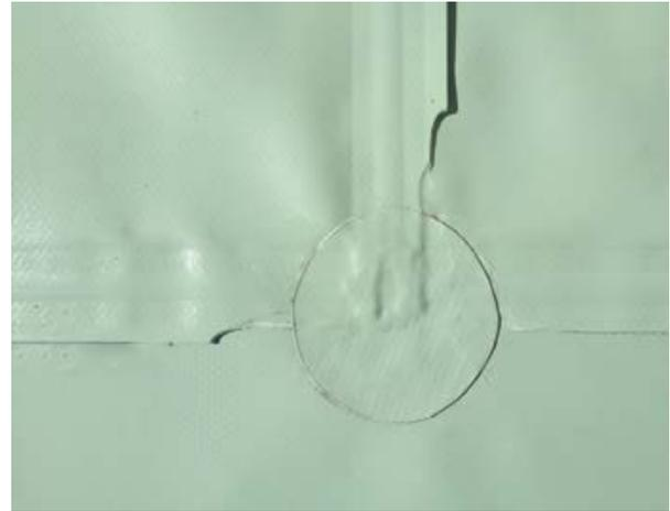
**8.1.8** Для разделения второго слоя гидроизоляционного покрытия на отдельные секции следует выполнить его соединение с первым. Присоединение должно выполняться по мере монтажа второго слоя путем приварки его краев сплошным швом к первому гидроизоляционному слою по периметру каждой отдельной карты-участка с помощью полуавтоматического или ручного сварочного оборудования.
