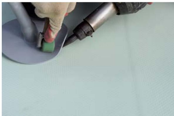
**8.1.11** При выполнении сварных соединений смежных полотен второго слоя покрытия (исключая швы, образующие герметичные секции) также необходимо производить проверку их герметичности согласно раздела 10 настоящего руководства. Качество сварных швов, полученных в процессе монтажа второго слоя гидроизоляционного покрытия, следует проверять инструментально с применением специального пробника качества шва.
