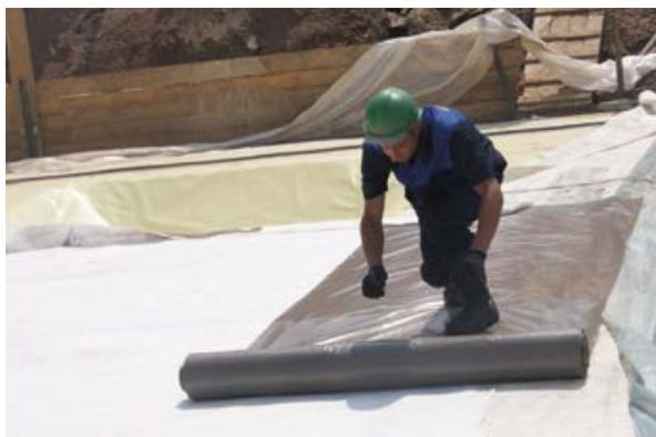
Минимальная толщина пленки при этом должна составлять не менее 200 мкм, так как при меньшей толщине пленка механически повреждается при перемещении рабочих, устройстве защитной стяжки и т.д.
