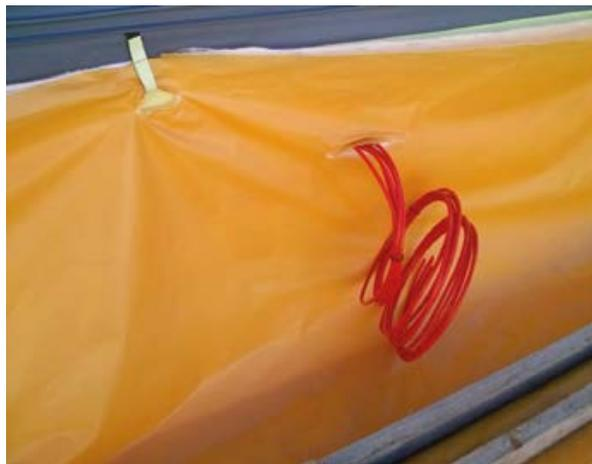
**6.2.5** После монтажа гидроизоляционного покрытия, сварки нахлестов и проверки их качества производится монтаж защитных слоев. Выбор защитных материалов осуществляется в соответствии с п. 3.2.1-3.2.4 настоящего руководства, где также описаны способы монтажа.
