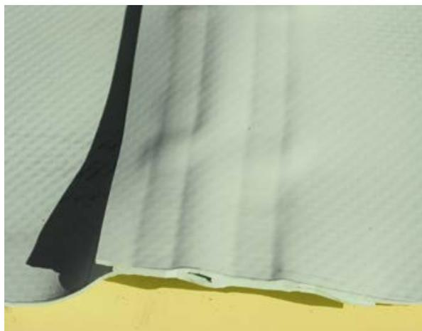
**8.1.7** Сварные швы второго слоя, выполненные автоматическим оборудованием, необходимо проверить под давлением воздуха. Т-образные соединения должны быть усилены.
