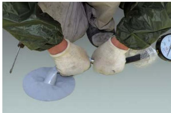
**10.10** Если применяются угловые инъекционные штуцеры, то их подсоединение к трубкам выполняется без применения стальных втулок. Крепление осуществляется через соединительные фитинги. Применение угловых штуцеров наиболее предпочтительно ввиду того, что они обеспечивают надежное присоединение трубок за счет возможности использования угловых и прямых соединительных фитингов.
