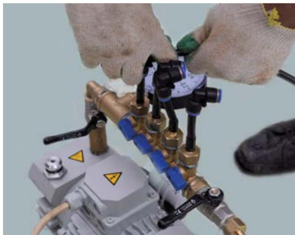
**10.13** После соединения трубок со штуцерами и вакуумным насосом выполняется откачка воздуха из паза пространства между гидроизоляционными мембранами до достижения разрежения в 0,5-0,6 бар. Достигнув этой величины, вакуумный насос останавливается, воздушная магистраль перекрывается и при помощи манометра отслеживается изменение давления в системе. Допустимым является повышение давления в карте не более чем на 20% (до значения -0,4-0,48 бар в течение 5 минут).
