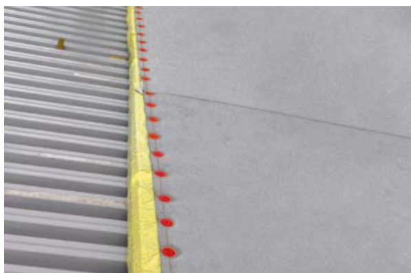
Рис. 3.1.7. Защита теплоизоляции от намокания.
