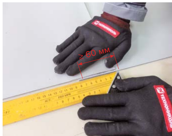
Минимальный нахлест полотен ПВХ-мембраны в зоне сварки.
