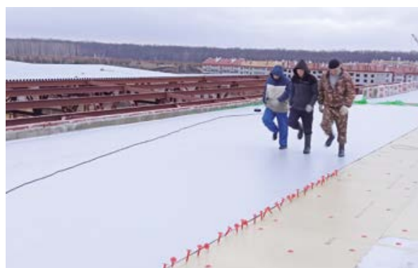
Рис. 5.4.2. Натяжение мембраны шаркающим движением ног.
