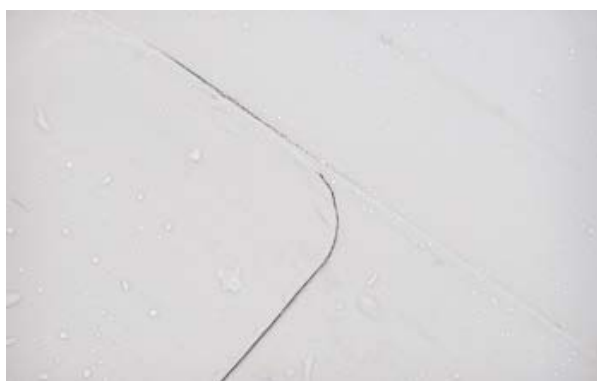
Рис. 5.4.1. Скругление углов мембраны.
