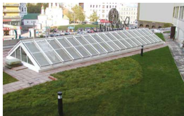
Рис. 2.5.4. Вид озелененной балластной кровли.
