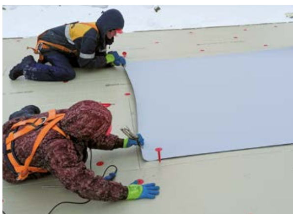
Рис. 5.4.5. Натяжение мембраны.
