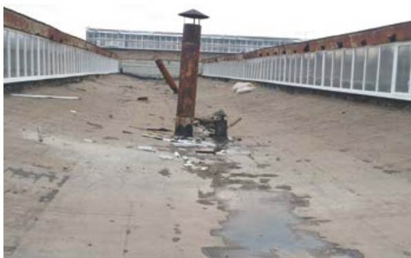
Рис. 2.4.3. Старая рулонная кровля до ремонта.
