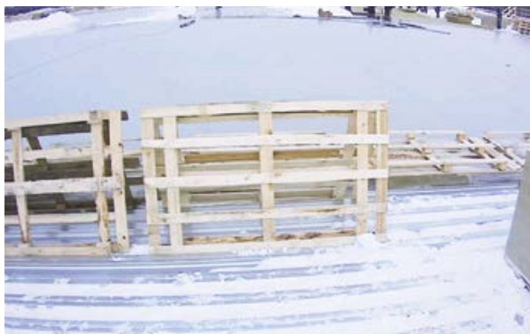
Рис. 3.1.4. Защита края кровельного пирога от хождения.
