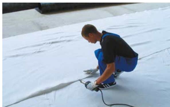
Рис. 3.4.1. Сварка полотнищ геотекстиля между собой.
