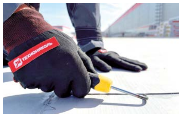
Рис. 5.2.10. Контроль при помощи специального пробника
