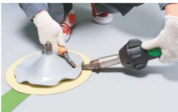
27. Сделайте воздушный карман с помощью латунного ролика.
