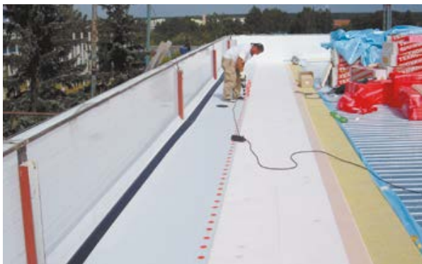
Рис. 3.6.14. Устройство парапетных и угловых ветровых зон с применением рулонов полимерной мембраны ТЕХНОНИКОЛЬ меньшей ширины.
