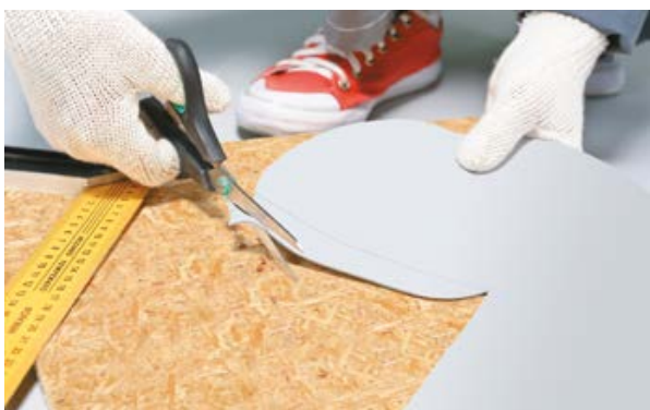
17. Закруглите углы с помощью ножниц.
