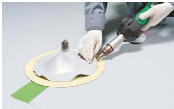
26. Точечно прихватите конус за «юбку» к основному кровельному ковро.
