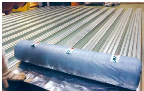
Рис. 3.2.2. Укладка пароизоляции Паробарьер С вдоль верхних полок профнастила.
