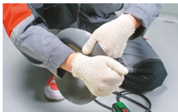
22. Растягивайте прогретый участок до получения «юбки», располагая руки, как показано на фото. Последовательно прогрейте и растяните заготовку по всей окружности.
