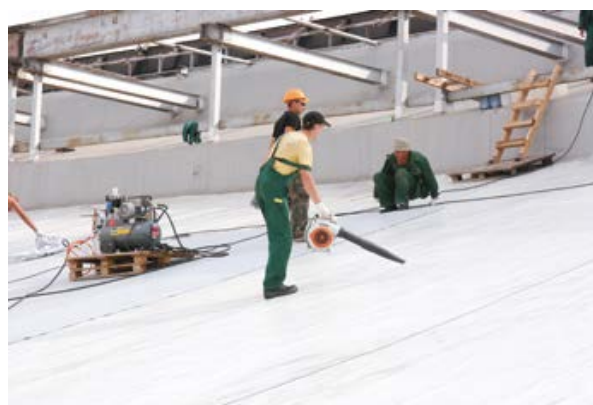
Рис. 2.4.9. Подготовка существующей кровли в качестве основания под приклейку: очистка, обеспыливание, праймирование, просушивание.
