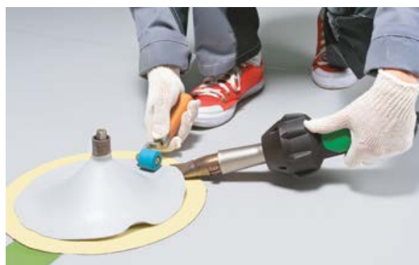
28. При этом давите латунным роликом «наружу», чтобы обеспечить необходимое натяжение мембраны.
