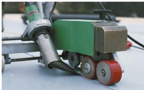
Рис. 5.2.1. Процесс автоматической сварки.
