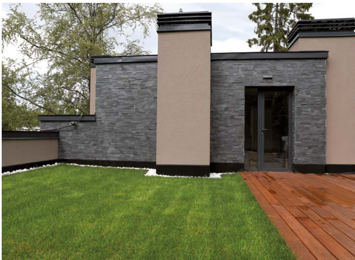
Рис. 2.5.7. Вид озелененной эксплуатируемой кровли.
