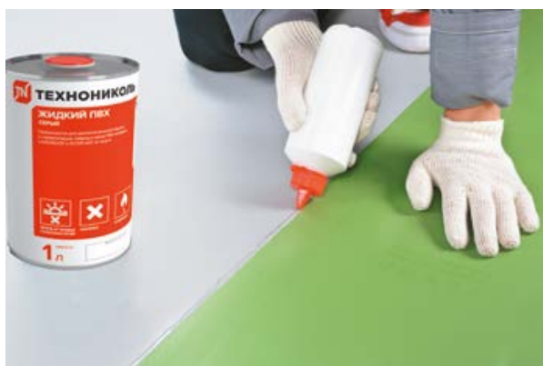
Рис. 3.5.2. Обработка стыка жидким ПВХ ТЕХНОНИКОЛЬ.
