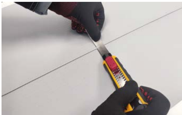
Рис. 5.2.15. Фиксация Т-образного шва металлической пластинкой.
