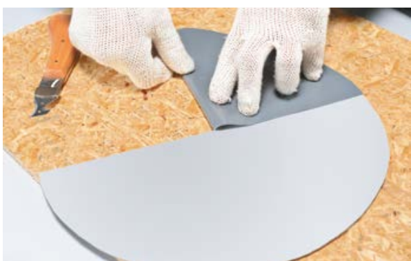
15. Загните получившийся сегмент и прикатайте его валиком.
