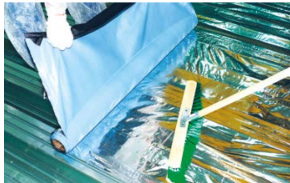
Рис. 3.2.3. Снятие антиадгезионной защитной пленки и последующая приклейка пароизоляции Паробарьер С с помощью прикатки мягкой щеткой.
