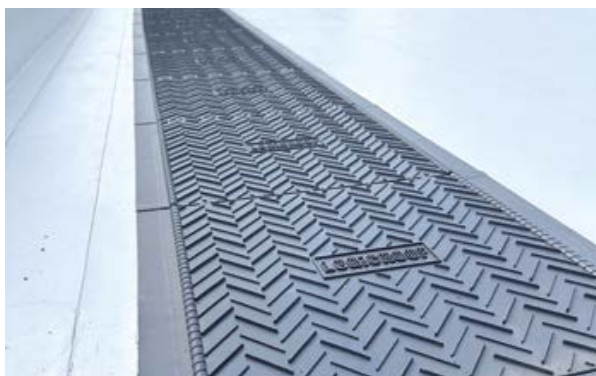
Пешеходная дорожка LOGICROOF Walkway Puzzle на кровле.
