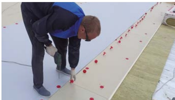
Рис. 5.4.4. Механическое крепление мембраны.
