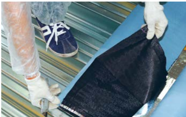
Рис. 3.2.3. Снятие антиадгезионной защитной пленки и последующая приклейка пароизоляции Паробарьер С с помощью прикатки мягкой щеткой.
