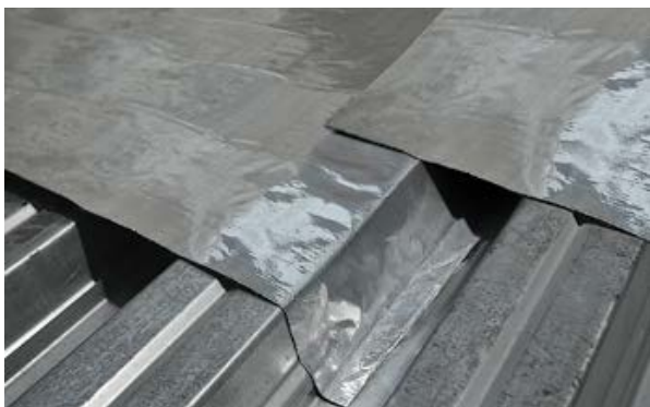
Рис. 3.2.4. Формирование продольного нахлеста пароизоляции Паробарьер С на профлисте.
