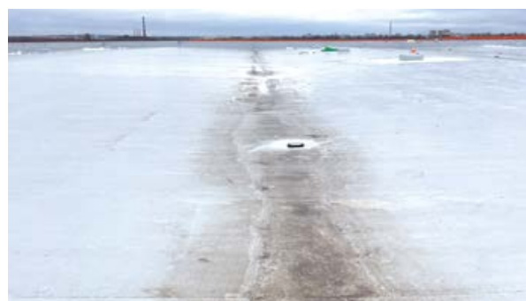
5.4.7. Зоны застоя воды на поверхности ПВХ-мембраны
