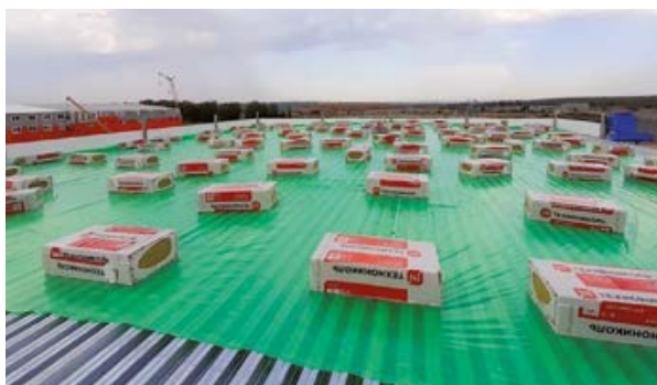
Рис. 3.1.5. Укладка пароизоляционной пленки ТЕХНОНИКОЛЬ.
