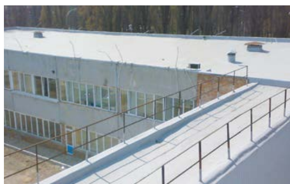
Рис. 2.4.6. Вид кровли после ремонта с применением клеевой системы из полимерных мембран ТЕХНОНИКОЛЬ с доутеплением облегченными термоплитами LOGICPIR PROF.
