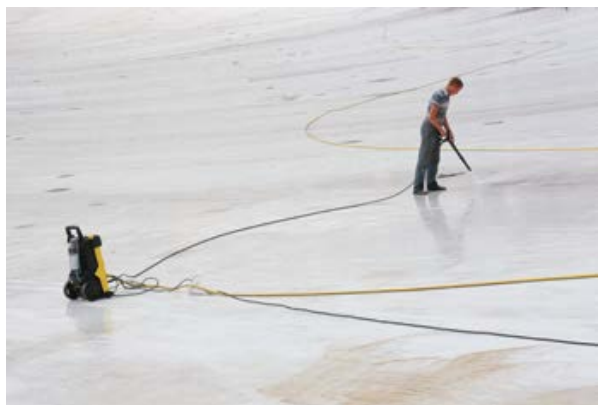
Рис. 2.4.9. Подготовка существующей кровли в качестве основания под приклейку: очистка, обеспыливание, праймирование, просушивание.
