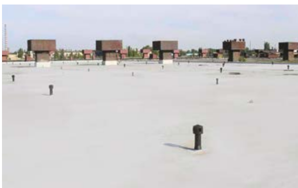
Рис. 2.4.6. Вид кровли после ремонта с применением клеевой системы из полимерных мембран ТЕХНОНИКОЛЬ с доутеплением облегченными термоплитами LOGICPIR PROF.
