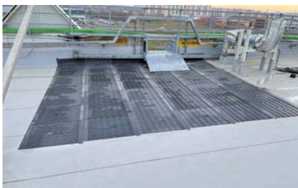
Широкая пешеходная дорожка с укладкой плит LOGICROOF Walkway Puzzle в несколько рядов.
