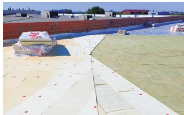
Рис. 3.4.4. Клиновидный утеплитель ТЕХНОНИКОЛЬ.
