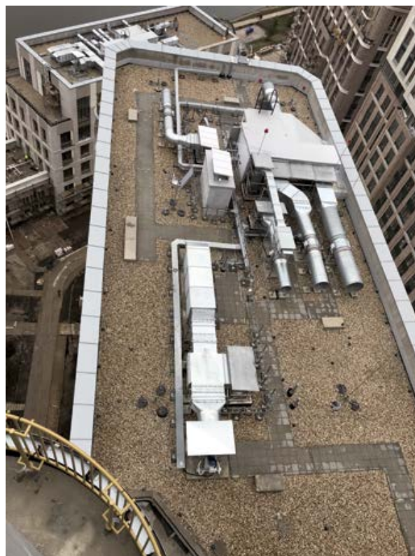
Рис. 2.5.1. Вид кровли с насыпным балластом.
