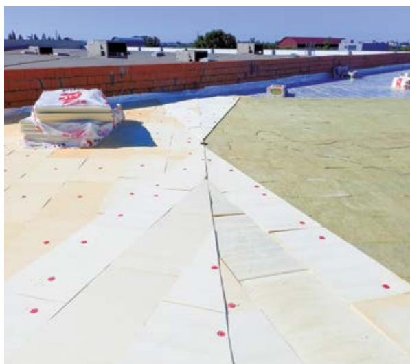
Рис. 3.4.18. Разуклонка в ендове между воронками.
