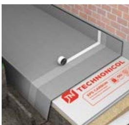
**6.** Скрепите геотекстиль для формирования целостности фильтрующего слоя. Используйте двух- или одностороннюю клейкую ленту. Если клейкая лента односторонняя, ширина должна быть не менее 50 мм.
