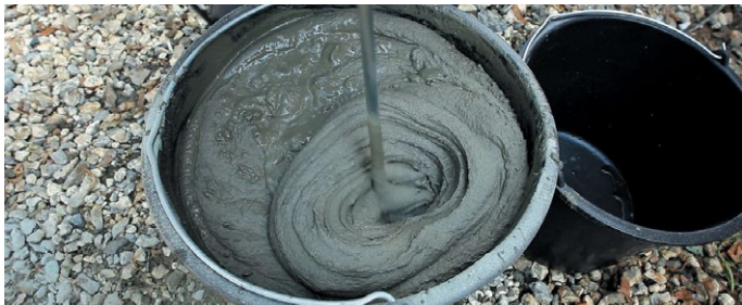
Рис. 25. Замешивание клея для приклейки теплоизоляции
