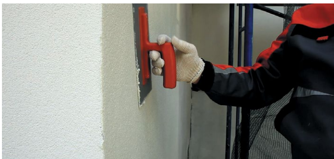
Рис. 39. Нанесение декоративного слоя штукатурки
