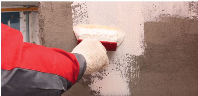
Рис. 38. Нанесение кварцевой грунтовки на поверхность базового штукатурного слоя
