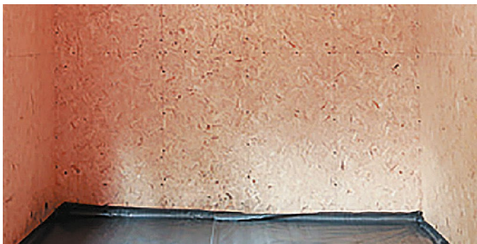
Рис. 23. Обшивка внутренней поверхности стен
