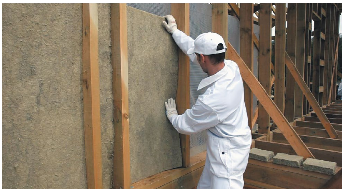
Рис. 20. Монтаж теплоизоляционных плит
