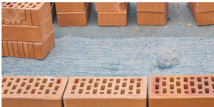
Рис. 7. Гидроизоляционная отсечка
