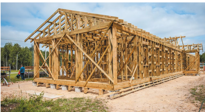
Рис. 18. Установка деревянного каркаса
