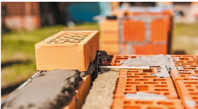
Рис. 14 а. Монтаж внешней версты после установки гибких связей
