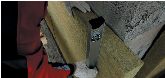
Рис. 29. Приклейка плиты тепло-, звукоизоляции к стене
