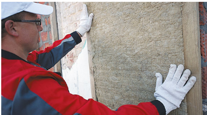
Рис. 2. Монтаж теплоизоляционных плит в вертикальный каркас
