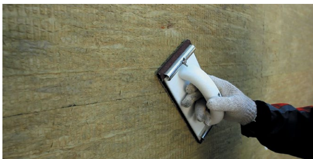
Рис. 32. Шлифовка стыков плит теплоизоляции наждачной бумагой
