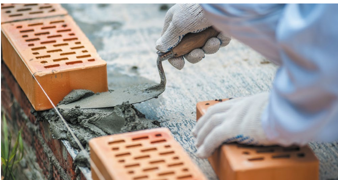
Рис. 9. Монтаж внешней версты
