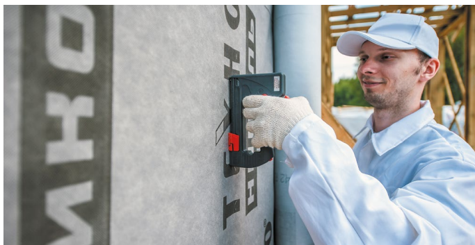
Рис. 21. Монтаж ветро-, влагозащитной мембраны
