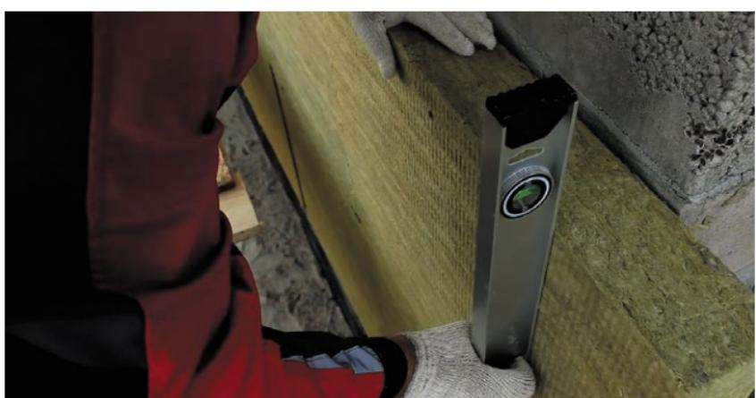
Рис. 8. Приклейка плиты тепло-, звукоизоляции к стене
