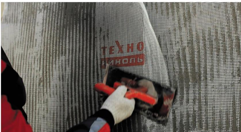
Рис. 16. Монтаж базового штукатурного слоя, армированного стеклосеткой
