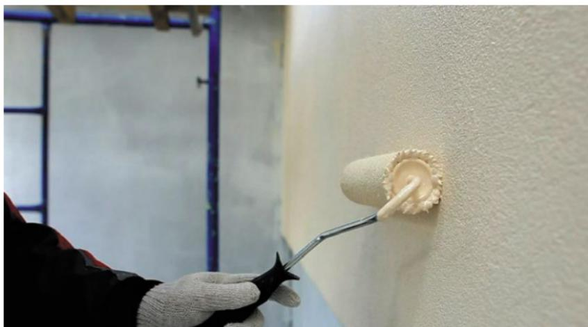
Рис. 19. Нанесение краски на поверхность фасада
