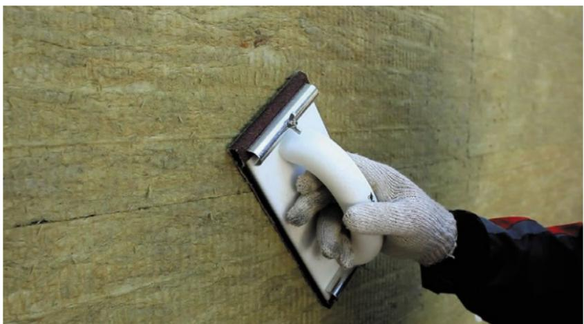
Рис. 12. Шлифовка стыков плит теплоизоляции наждачной бумагой
