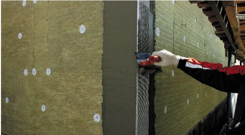
Рис. 15. Установка усиливающих профилей на углах здания
