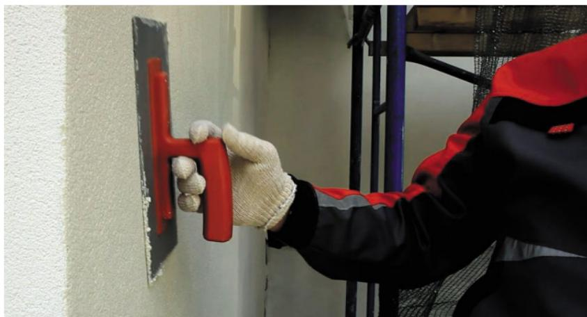
Рис. 18. Нанесение декоративного слоя штукатурки
