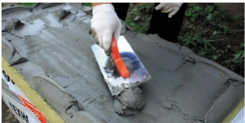
Рис. 6. Нанесение клея на плиту контурно-маячковым методом приклейки
