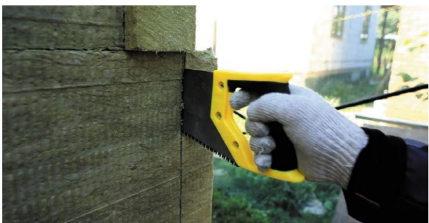
Рис. 10. Зубчатая перевязка плит на наружных углах здания
