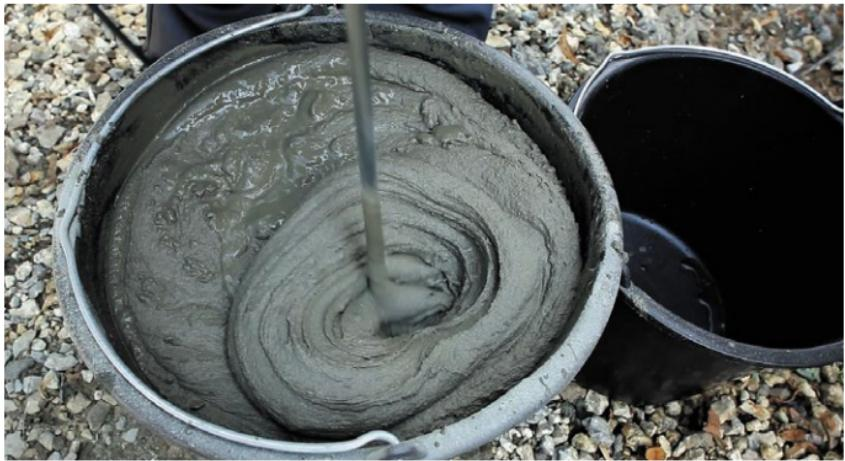
Рис. 3. Замешивание клея для приклейки теплоизоляции
