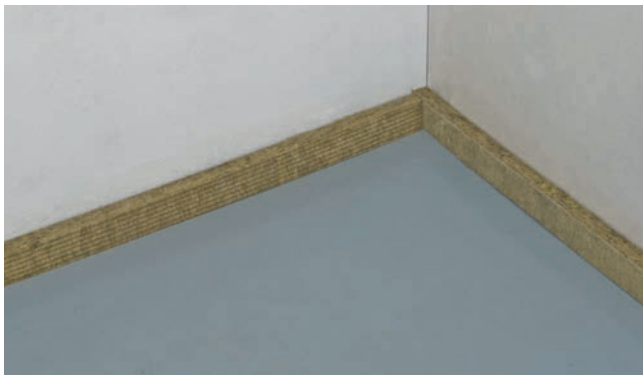
Рис. 6. Выравнивание пола, монтаж полос из каменной ваты по периметру
