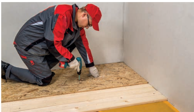
Рис. 4. Монтаж чернового пола
