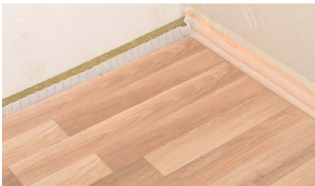
Рис. 15. Укладка ламината с зазором до стены 10 мм (в случае подрезки звукоизоляционных плит по периметру на уровне стяжки)
