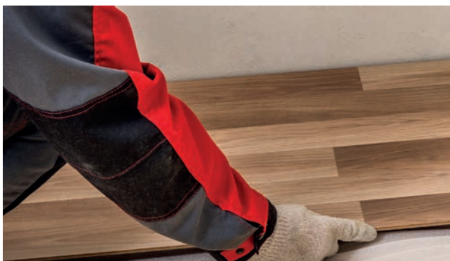
Рис. 13. Монтаж планок ламината
