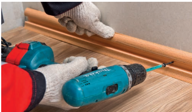
Рис. 16. Крепление плинтуса
