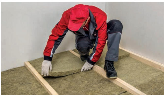
Рис. 2. Монтаж теплоизоляции враспор между лагами
