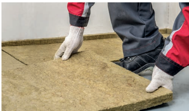
Рис. 7. Укладка плит ТЕХНОФЛОР СТАНДАРТ
