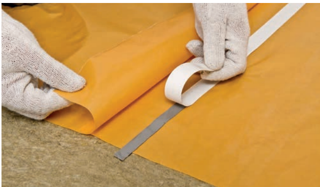
Рис. 3. Монтаж и проклейка нахлестов пароизоляционной пленки
