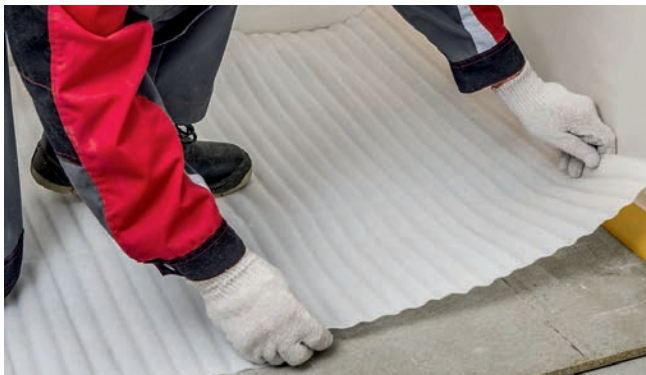
Рис. 12. Укладка подложки под финишное покрытие пола Далее производим монтаж планок ламината.
