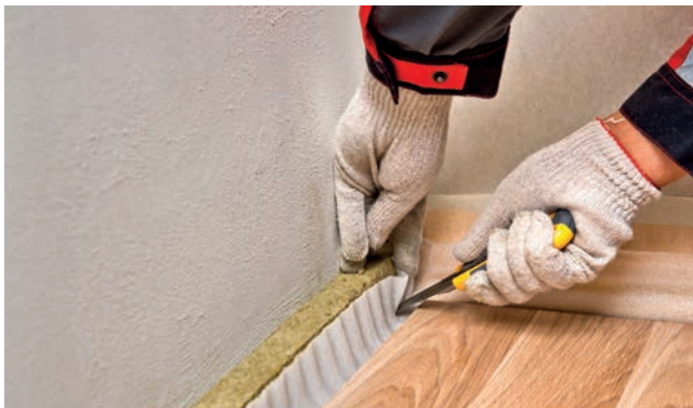
Рис. 14. Подрезка звукоизоляционных плит по периметру на уровне чистого пола
