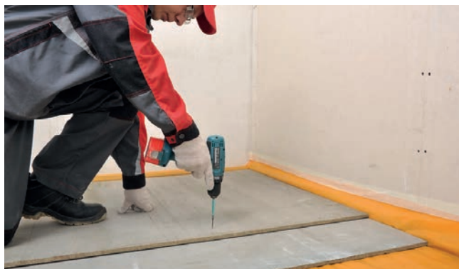
Рис. 9. Устройство сборной стяжки
