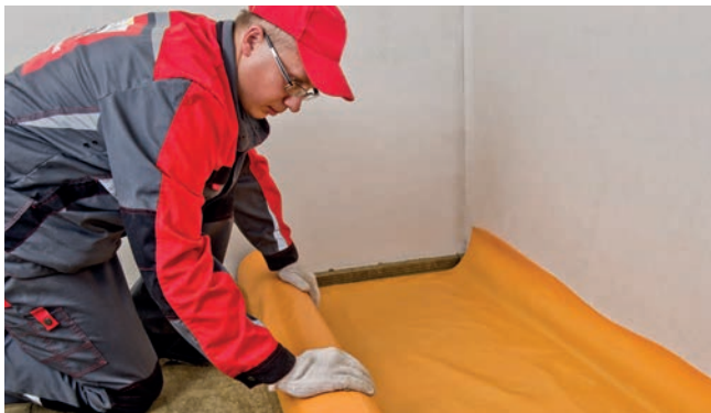
Рис. 8. Укладка гидроизоляции
