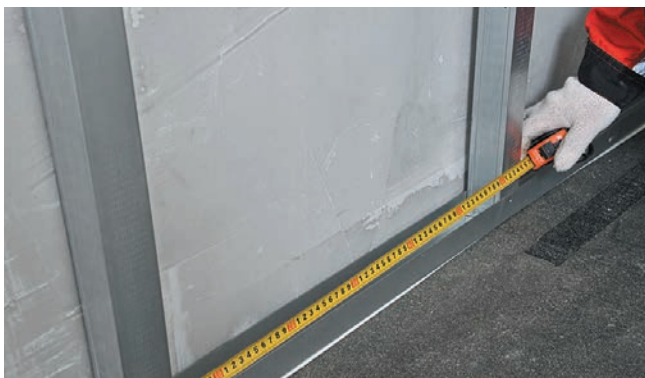
Рис. 11. Установка направляющего и стойчного профилей
