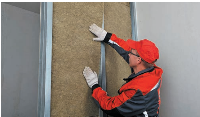
Рис. 6. Монтаж тепло-, звукоизоляционных плит
