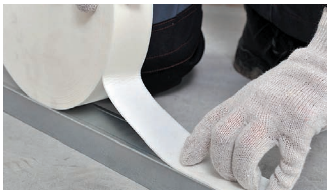
Рис. 3. Схема расположения и приклейка уплотнительной ленты в каркасе
