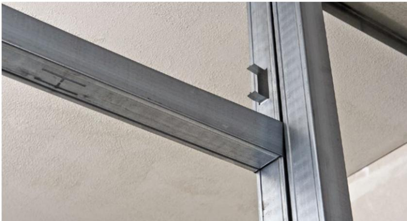
Рис. 4. Установка стоечного профиля (продолжение)
