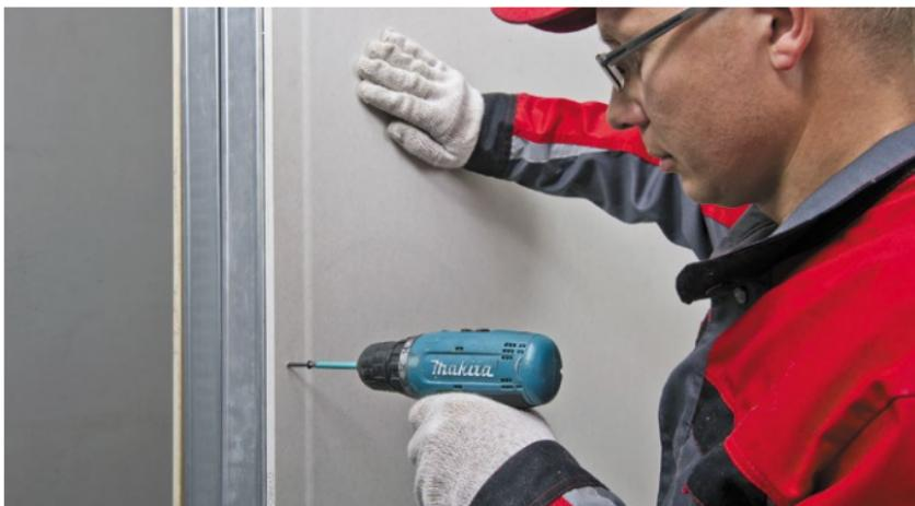
Рис. 13. Обшивка стен листами ГКЛ
