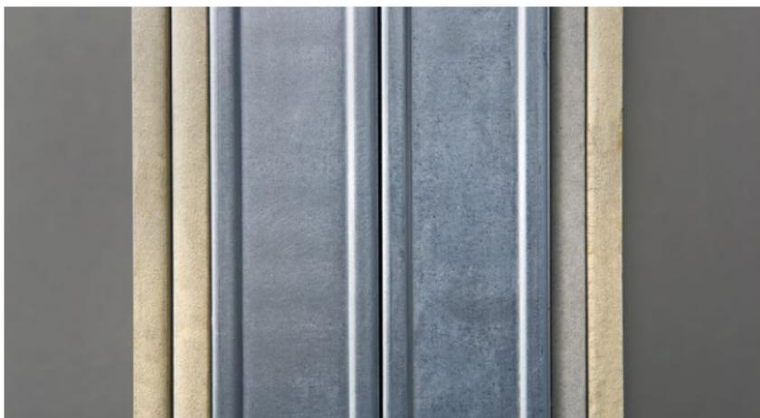
Рис. 7. Обшивка второй стороны перегородки листами ГКЛ
