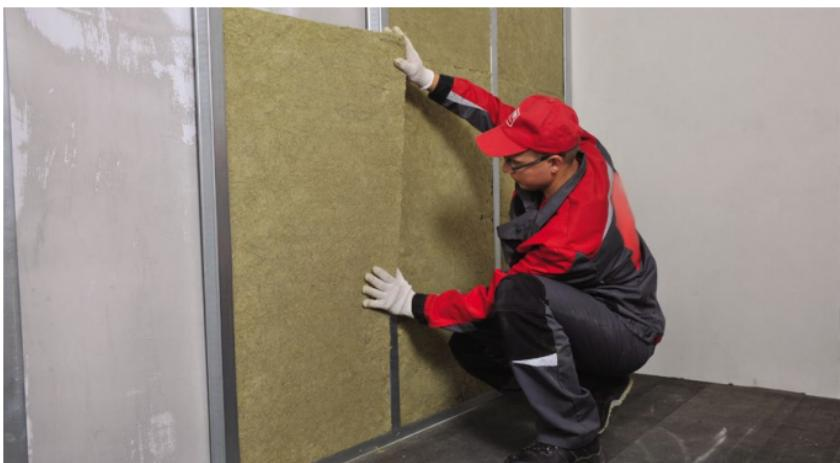
Рис. 12. Монтаж тепло-, звукоизоляционных плит
