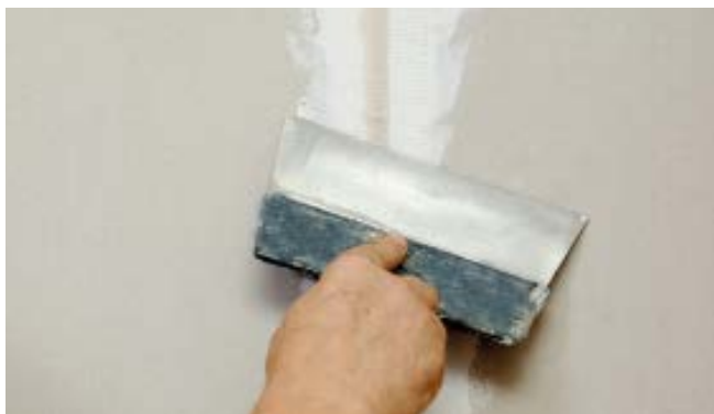
Рис. 8. Заделка швов
