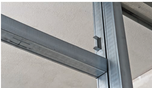
Рис. 4. Установка стоечного профиля
