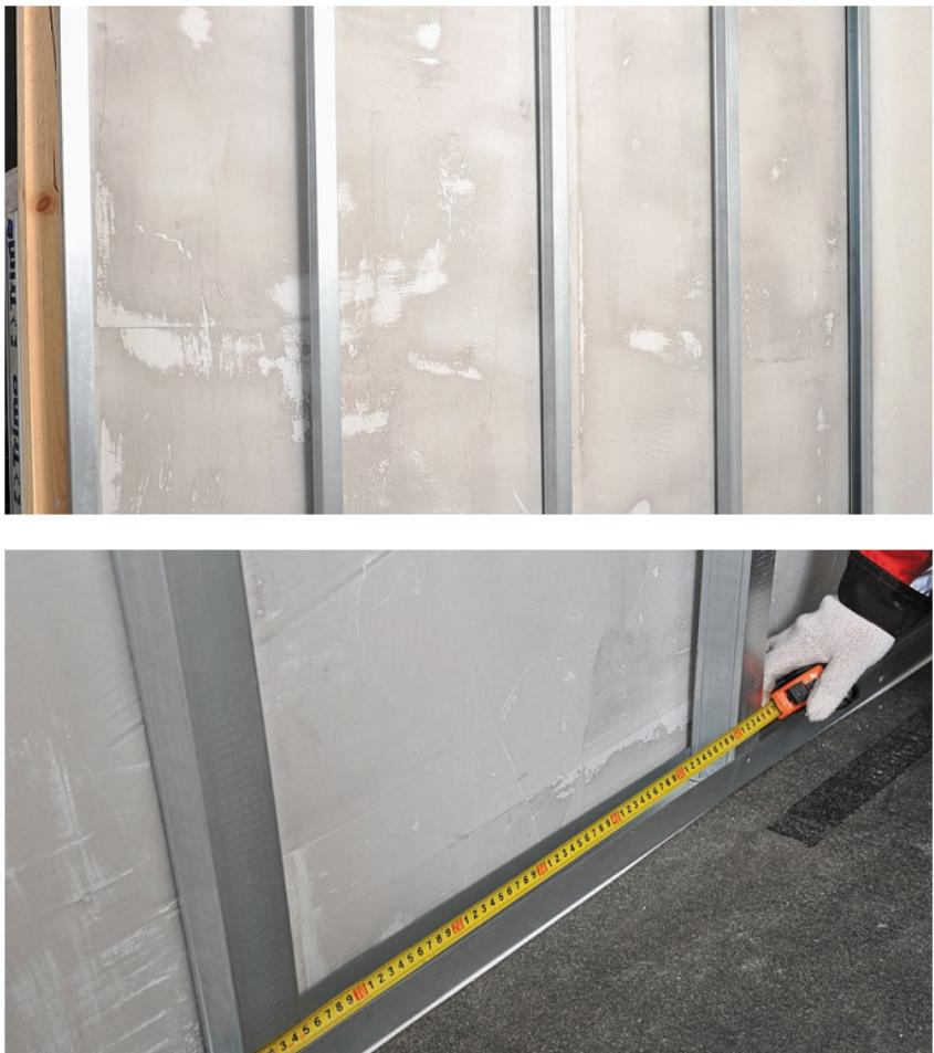
Рис. 11. Установка направляющего и стоечного профилей
