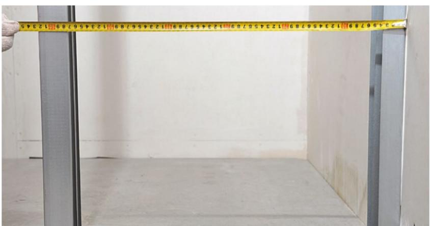
Рис. 4. Установка стоечного профиля
