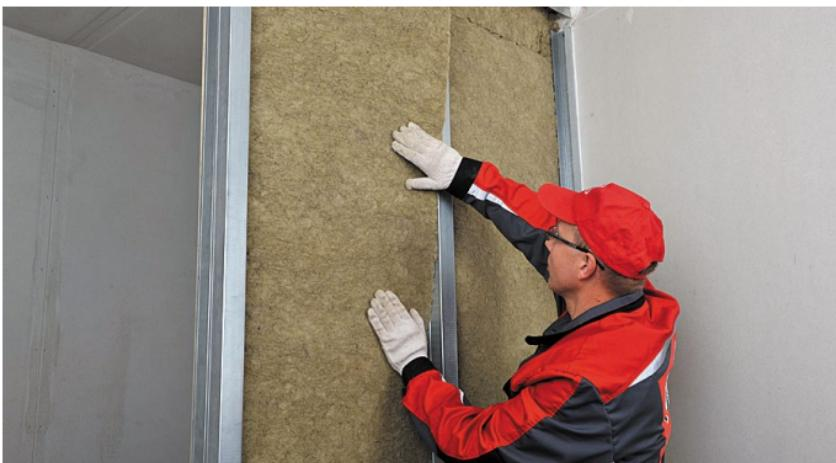
Рис. 6. Монтаж тепло-, звукоизоляционных плит
