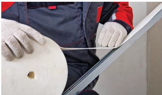
Рис. 10. Приклейка уплотнительной ленты к профилям и резка профиля
