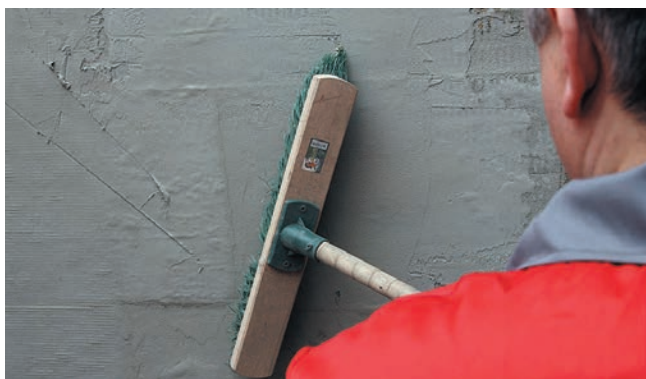
Рис. 9. Подготовка помещения к работе
