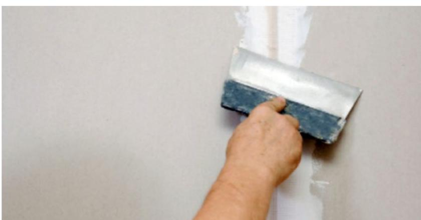
Рис. 8. Заделка швов
