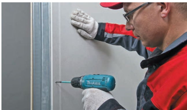
Рис. 13. Обшивка стен листами ГКЛ
