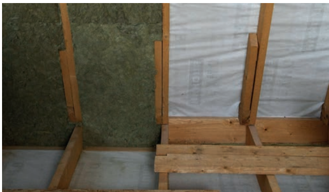
Рис. 2. Подготовленная система для дальнейшего монтажа теплоизоляции
