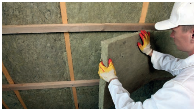
Рис. 4. Укладка второго слоя теплоизоляции
