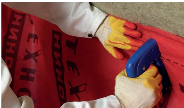
Рис. 5. Укладка и фиксация пароизоляционной пленки
