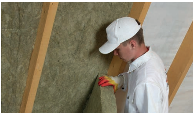
Рис. 3. Монтаж теплоизоляции враспор между стропилами
