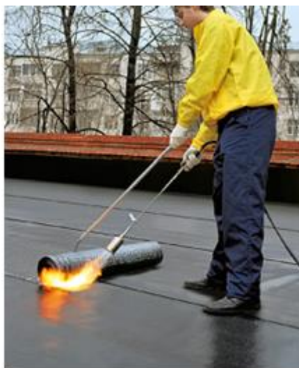
Рисунок 4.9 – Положение рабочего при наклейке рулона
