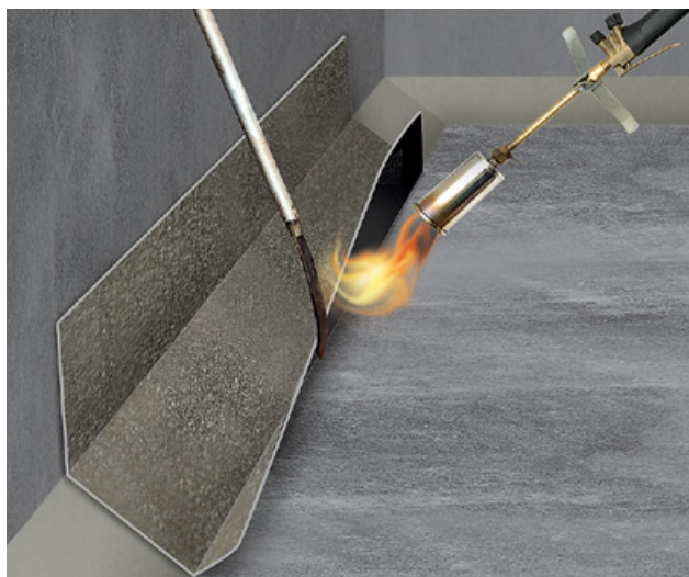
Рис. 4.7. Устройство слоя усиления при переходе с горизонтальной поверхности на вертикальную
