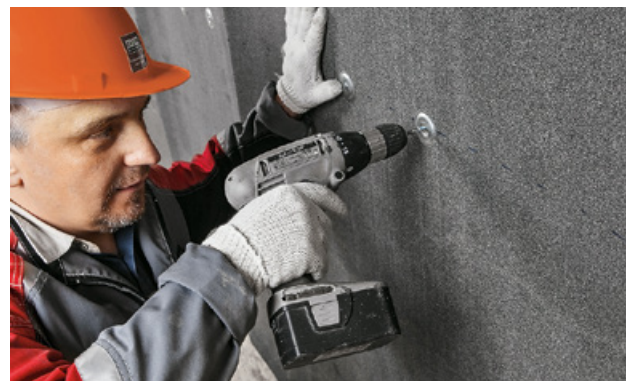
Рис. 2.3. Метод свободной укладки
