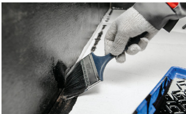
Рис. 3.4. Нанесение праймера кистью в труднодоступном месте (переход с горизонтальной поверхности на вертикальную)
