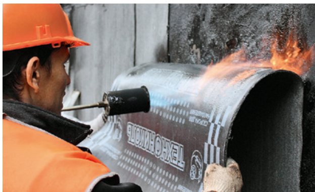
Рис. 2.2. Метод сплошного наплавления
