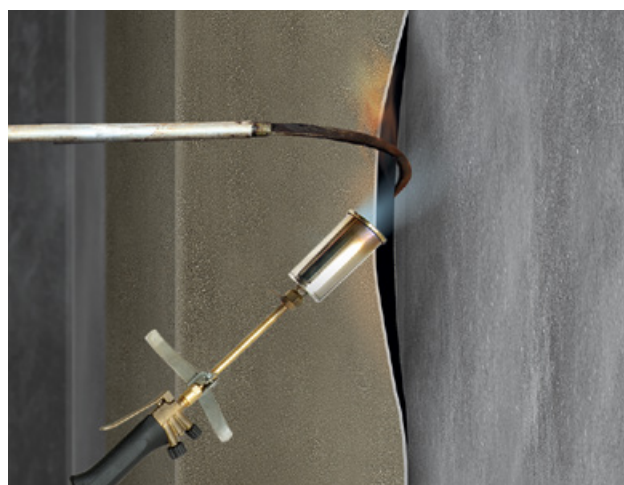
Рис. 4.10. Устройство слоя усиления внешнего угла
