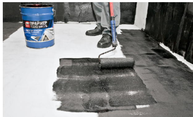
Рис. 3.3. Нанесение праймера валиком
