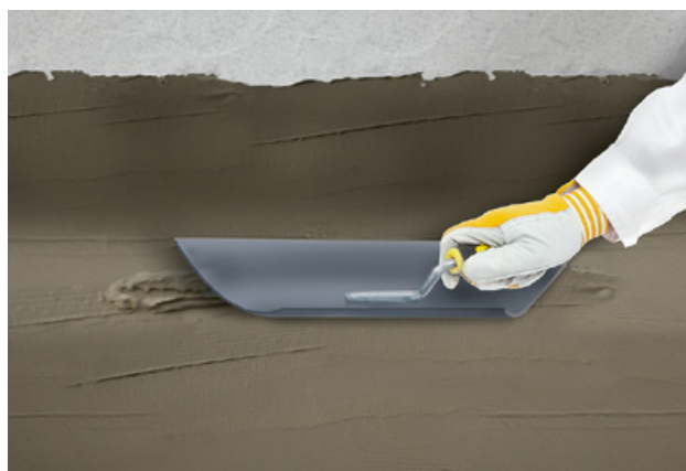
Рис. 3.1. Устройство галтели
