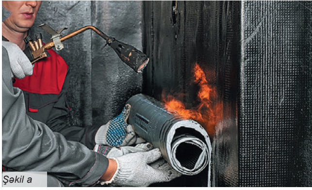
Şəkil 2.2. İkiqat hidroizolyasiya membranı texnoelast bünövrə (şəkil a) və birqatlı hidroizolyasiya membranı TERRA texnoelast bünövrə (şəkil b)
