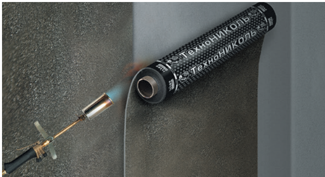
Şəkil 5.6. Rulonun sonrakı mexaniki fiksasiyası ilə üst-üstə düşmələrin qaynaqlanması
