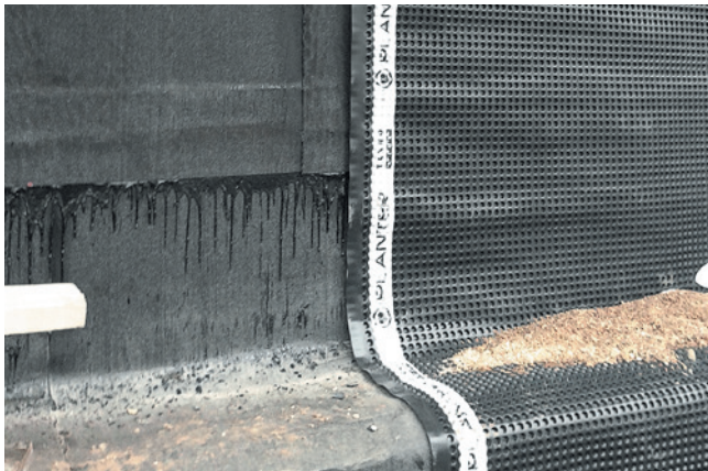
Şəkil 4.20. Hidroizolyasiya membranının PLANTER standard profilənmiş membran və XPS TEXNONİKOL CARBON PROF ekstrüziya edilmiş penopolistirol ilə qorunması
