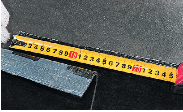
Şəkil 4.4. Texnoelast bünövrə materiallarını düzərkən yan üst-üstə düşmələrə nəzarət
