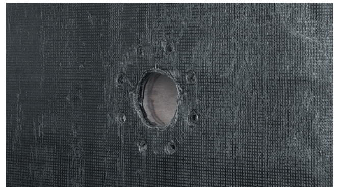
Şəkil 6.12. Boruların keçdiyi zonada Texnoelast bünövrəsinin birinci və ikinci qatının rulonlarının döşənməsi
