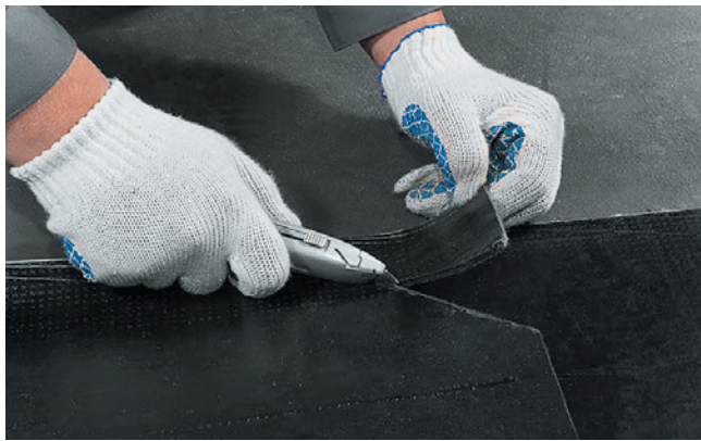
Şəkil 4.5. T formalı birləşmədə rulon bucağının kəsilməsi
