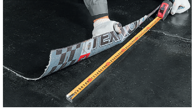
Şəkil 4.13. Birinci və ikinci qatların rulonları arasında üst-üstə düşmələrin qoyulması
