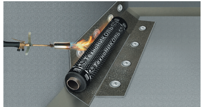
Şəkil 5.7. Rulonun gücləndirmə qatına əridilib birləşdirilməsi
