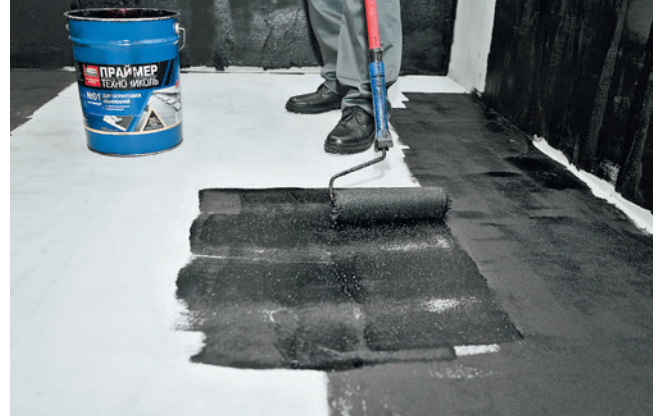
Şəkil 3.5. Praymerin çəkilməsi
