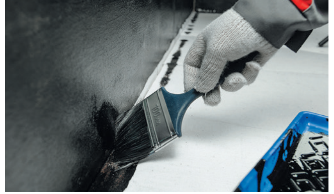
Şəkil 3.7. Künc zonasında fırça ilə praymerin çəkilməsi
