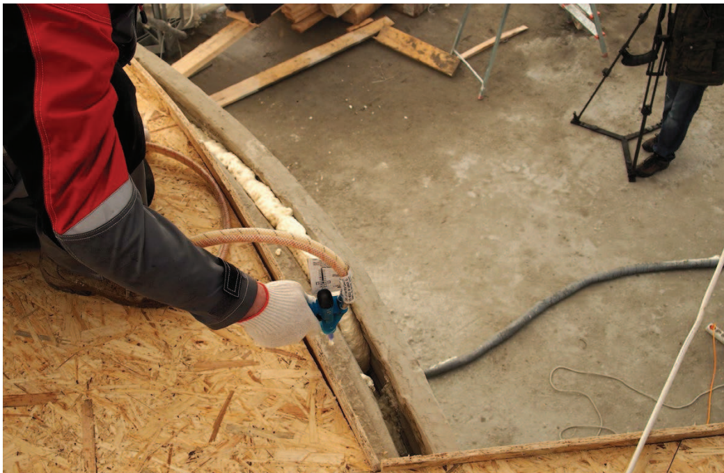
Для теплоизоляции фасадов на демонстрационном объекте в Ступино применены сразу две технологии: из засыпного теплоизоляционного материала LOGICPIR на одной части дома и заливного полиуретанового состава на другой
