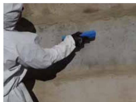
Очистка основания от мусора
