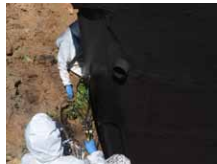
Нанесение выше, полосами 1-1,5 метра
