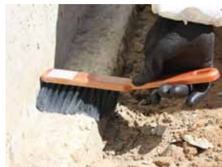
Очистка основания от пыли
