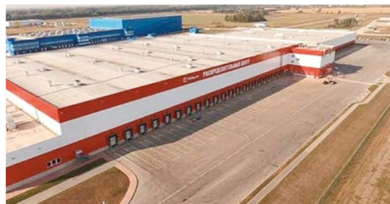
Распределительный центр X5 Retail Group, Новосибирск
