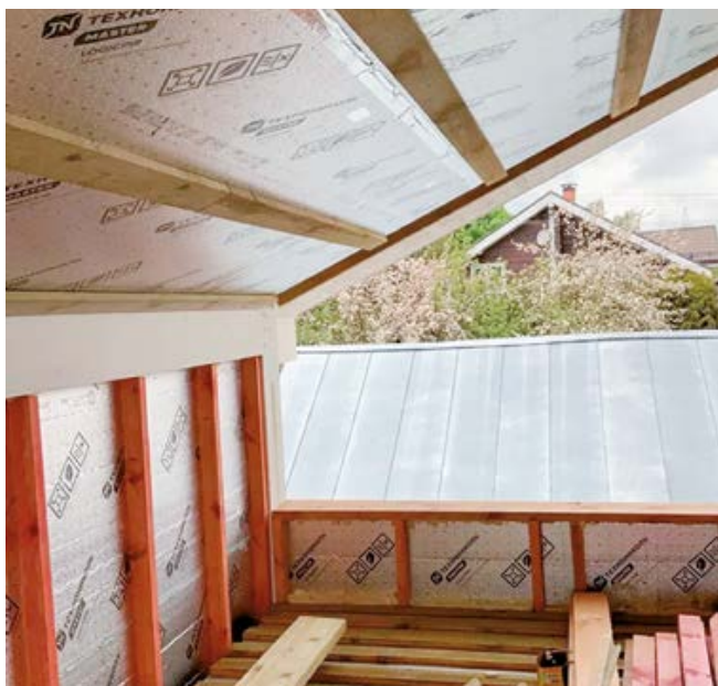
Контрутепление скатной кровли
