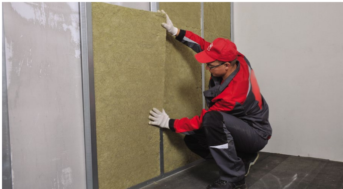
Рис. 12. Монтаж тепло-, звукоизоляционных плит
