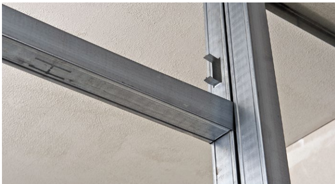
Рис. 4. Установка стоечного профиля (продолжение)
