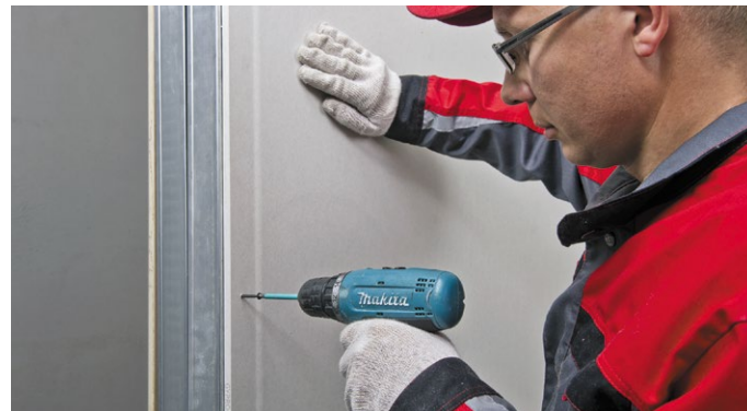
Рис. 13. Обшивка стен листами ГКЛ
