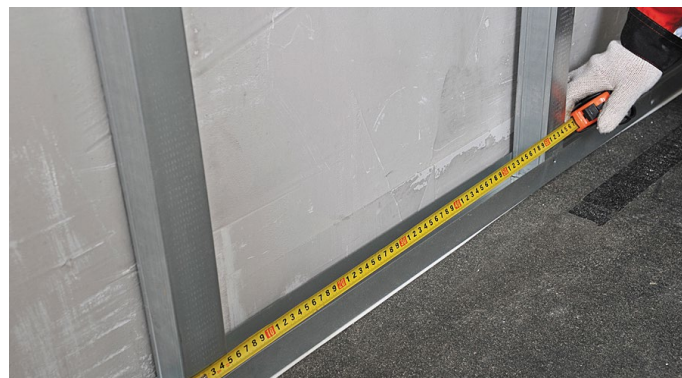
Рис. 11. Установка направляющего и стоечного профилей
