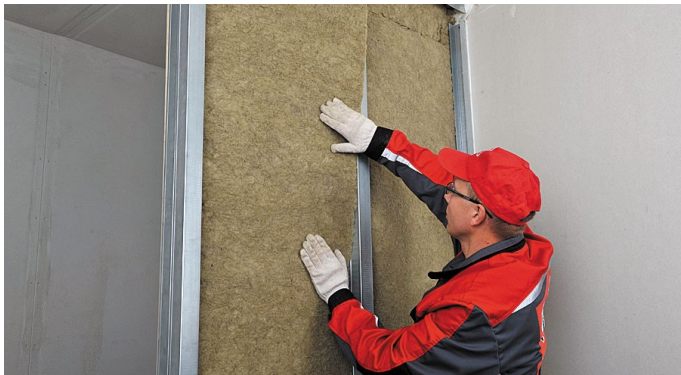
Рис. 6. Монтаж тепло-, звукоизоляционных плит
