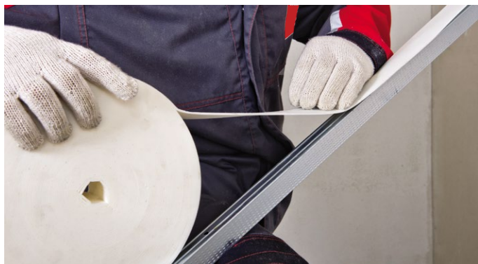
Рис. 10. Приклейка уплотнительной ленты к профилям и резка профиля
