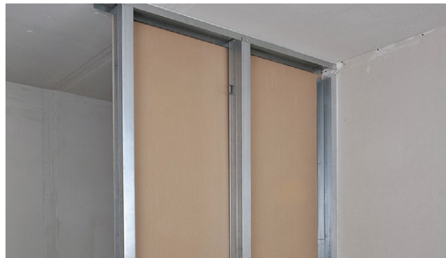
Рис. 5. Обшивка первой стороны перегородки листами ГКЛ
