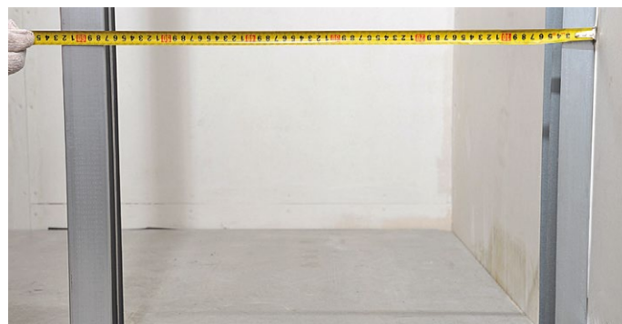
Рис. 4. Установка стоечного профиля
