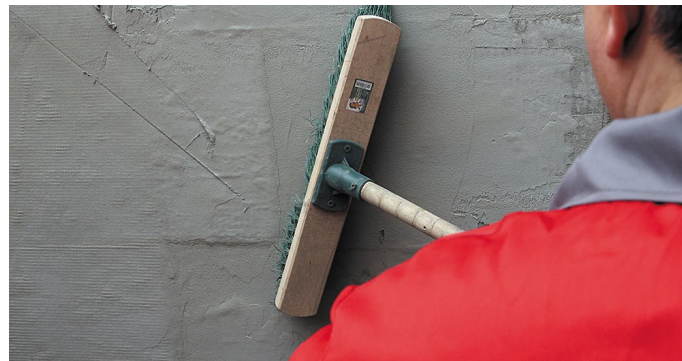
Рис. 9. Подготовка помещения к работе
