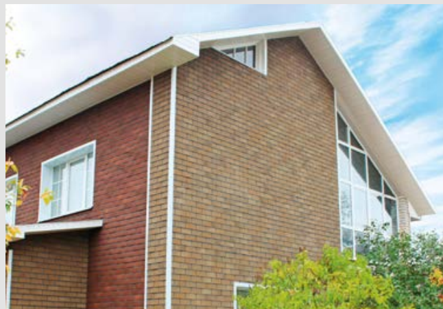
Объект «ПОСЛЕ». Коллекция КИРПИЧ, цвет Терракотовый кирпич и Песчаный кирпич
