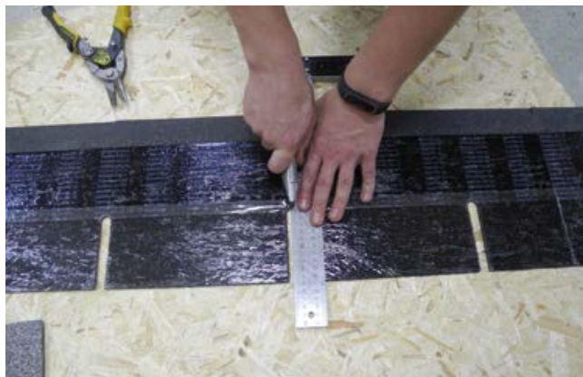
Рис. 13. Деление плитки на лепестки
