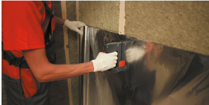
Рис. 3.1. Монтаж пароизоляции
