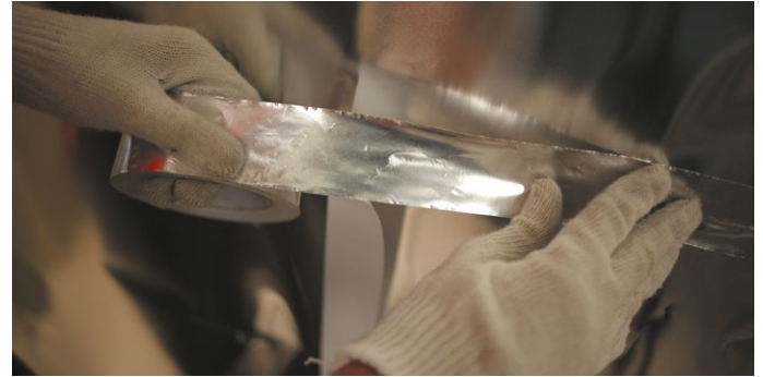
Рис. 3.2.б. Проклейка стыков пароизоляции
