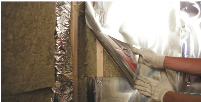
Рис. 3.2.а. Проклейка стыков пароизоляции
