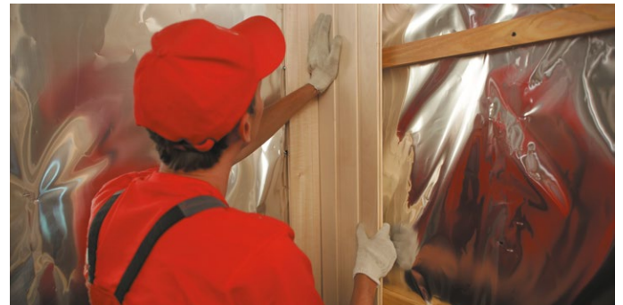
Рис. 4.1. Устройство внутренней обшивки
