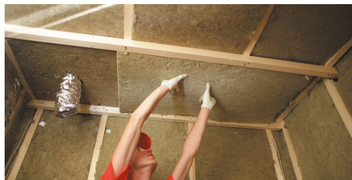
Рис. 2.1. Укладка плит теплоизоляции
