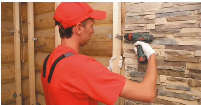
Рис. 1.1. Установка каркаса под теплоизоляцию
