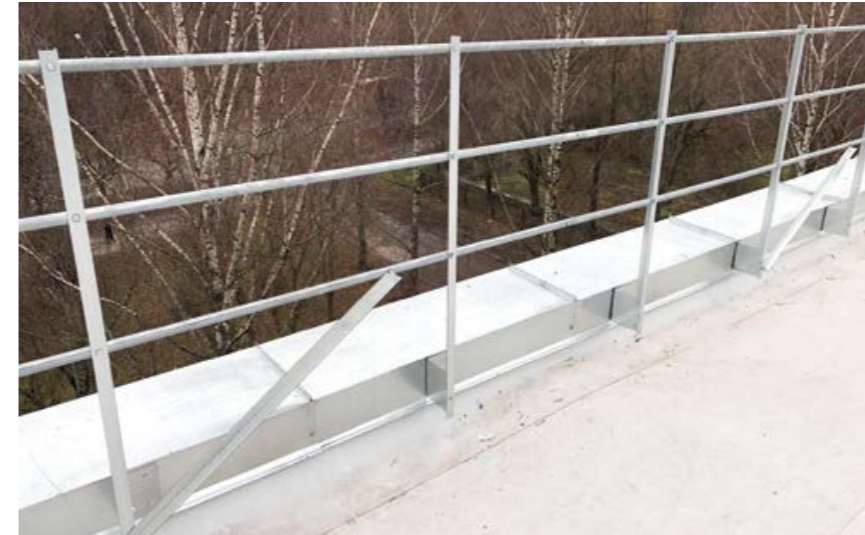
Установка ограждений ТН на парапет
