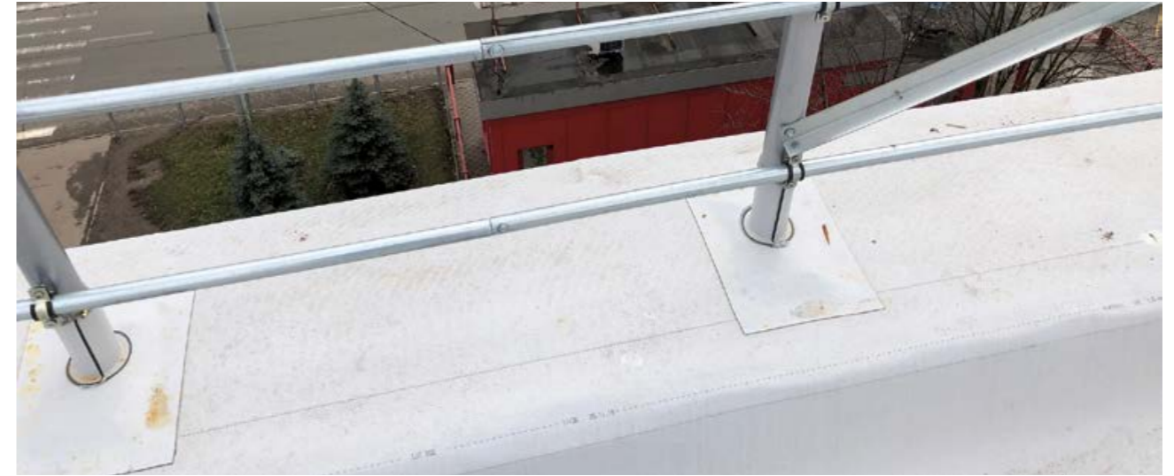
Установка ограждений ТН на парапет
