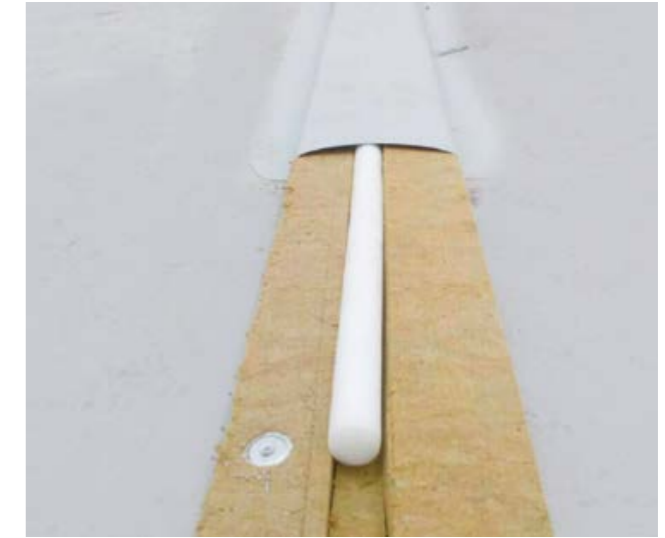
Устройство деформационного шва
