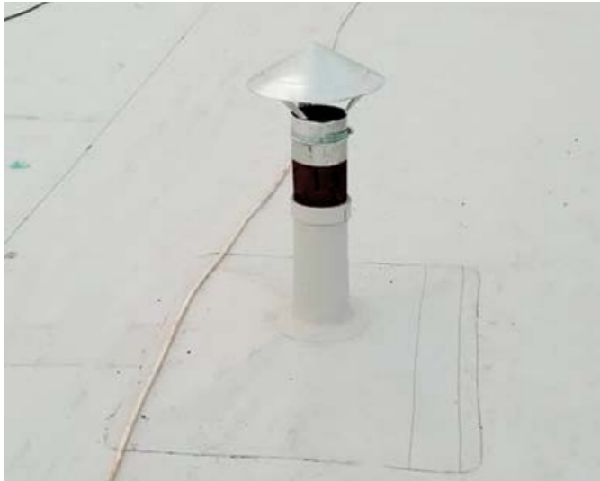
Примыкание к трубным проходкам
