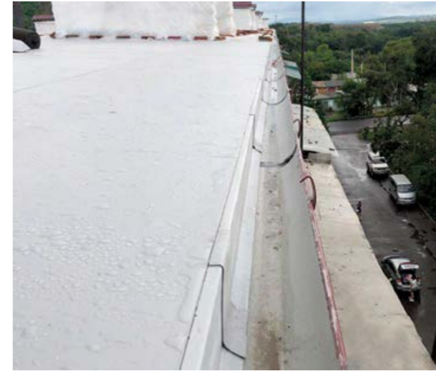
Устройство карнизного свеса
