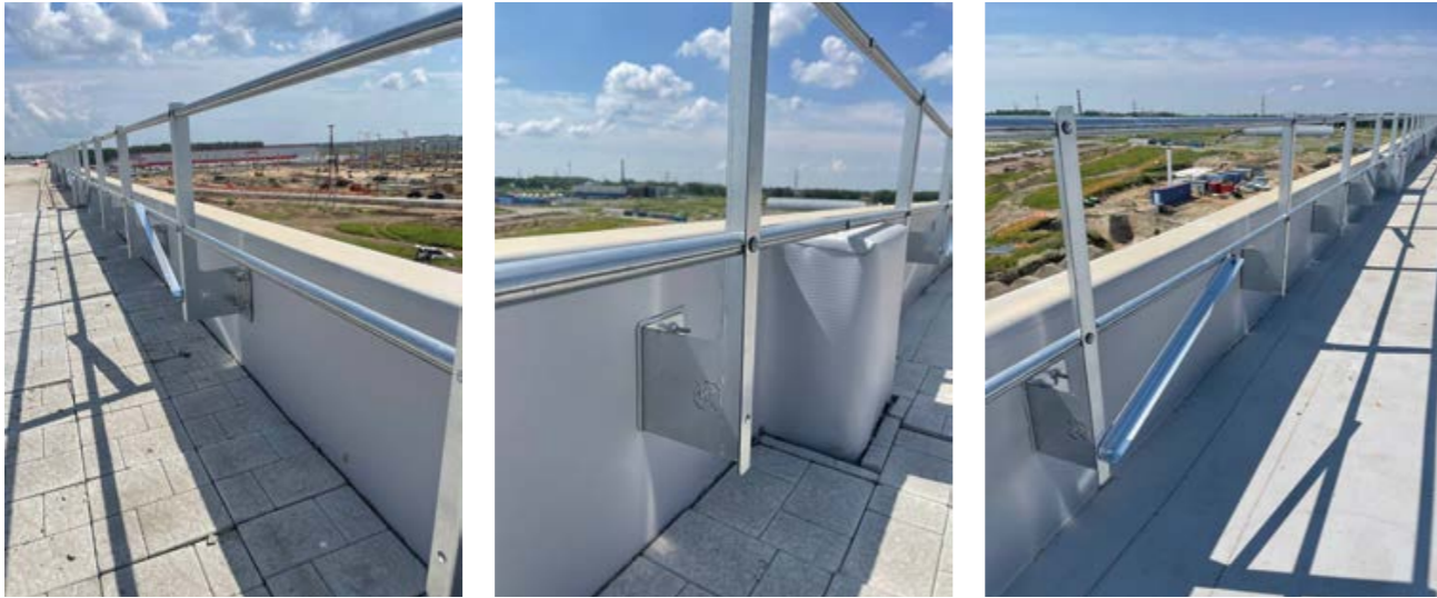
Установка ограждений ТН на парапет
