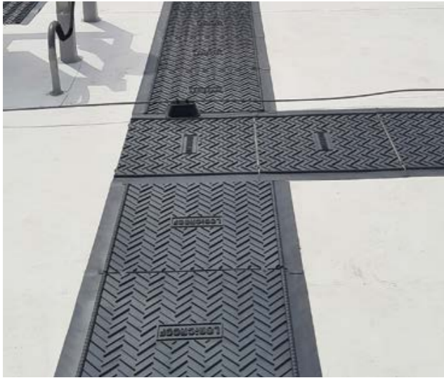
Схема устройства дорожки проходов из LOGICROOF Walkway Puzzle
