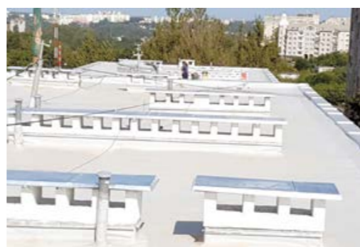
Примеры кровель, выполненных с использованием ПМ
