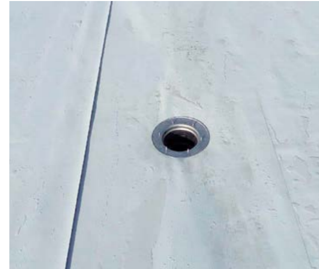
Устройство водоприемной воронки
