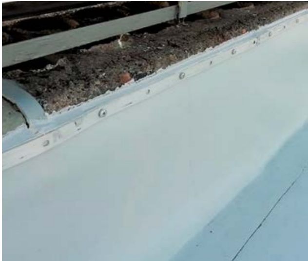
Примыкание к вертикальной поверхности
