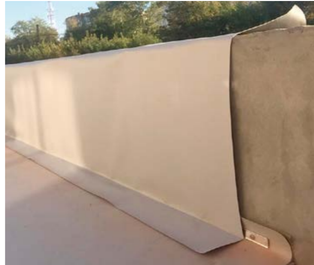
Примыкание к вертикальной поверхности с заведением ПМ за парапет
