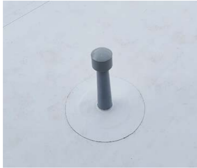
Примыкание к кровельному аэратору
