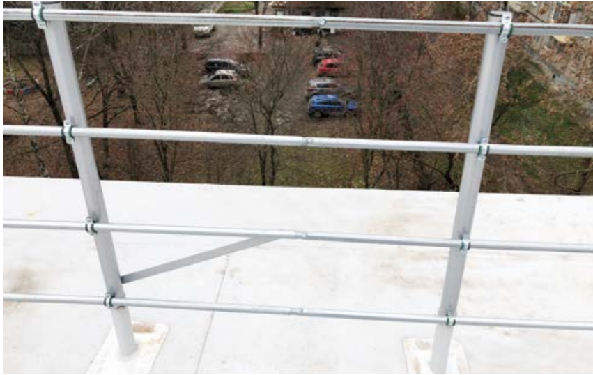
Установка ограждений (крепление в брус)
