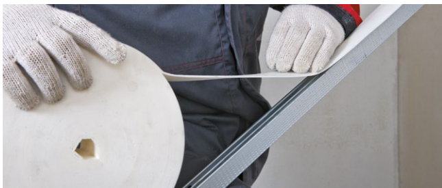
Рис. 6.9. Приклейка уплотнительной ленты к профилям
