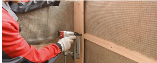
Рис. 7.48. Устройство внутренней обшивки
