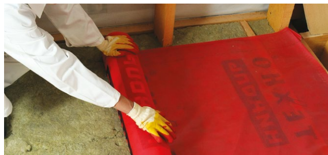
Рис. 4.12. Монтаж ветро-, влагозащитной мембраны
