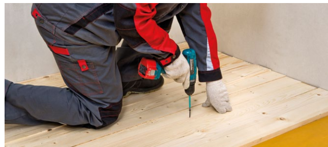
Рис. 5.4.а. Монтаж чернового пола
