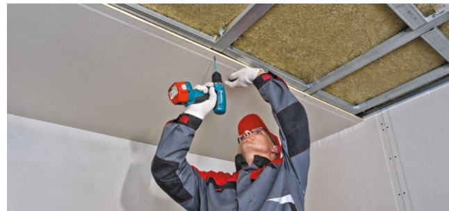
Рис. 5.25. Обшивка листами ГКЛ и/или ГВЛ
