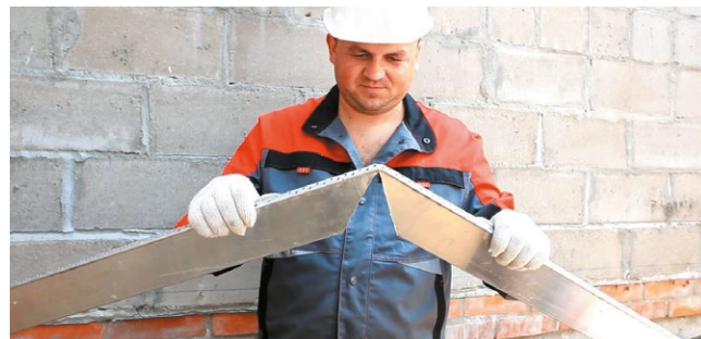
Рис. 7.26.а. Установка опорного профиля для первого ряда теплоизоляции с применением алюминиевого начального профиля
