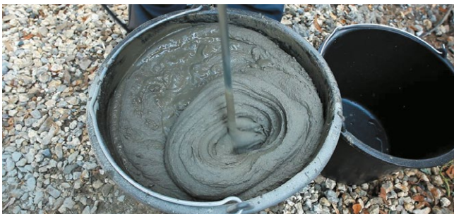
Рис. 7.27. Замешивание клея для приклейки теплоизоляции
