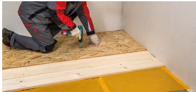
Рис. 5.4.б. Монтаж чернового пола
