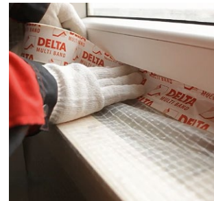
Рис. 7.53. Проклейка примыканий пароизоляции к стенам и окну
