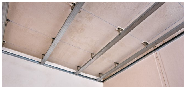
Рис. 5.23. Установка подвесов и потолочного профиля
