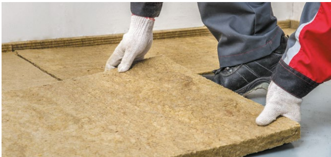
Рис. 5.8. Укладка плит ТЕХНОФЛОР СТАНДАРТ
