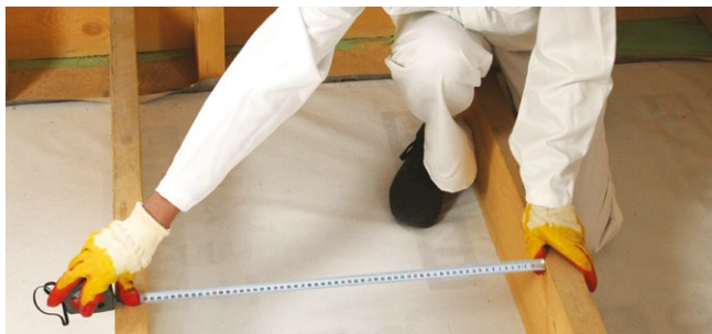
Рис. 4.9. Смонтированная пароизоляционная пленка
