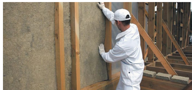
Рис. 7.21. Монтаж теплоизоляционных плит
