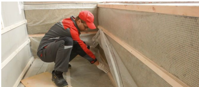
Рис. 7.51. Монтаж пароизоляционной пленки
