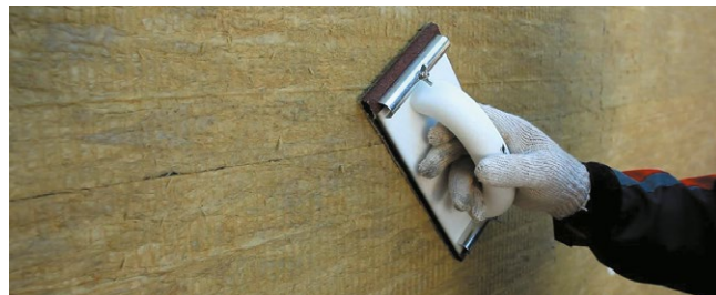
Рис. 7.34. Шлифовка стыков плит теплоизоляции наждачной бумагой
