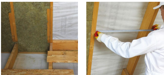
Рис. 4.2. Подготовленная система для дальнейшего монтажа теплоизоляции
