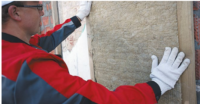
Рис. 7.2. Монтаж теплоизоляционных плит в вертикальный каркас
