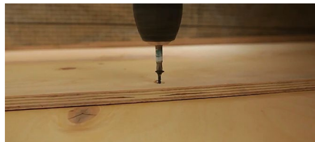
Рис. 7.54. Установка покрытия пола
