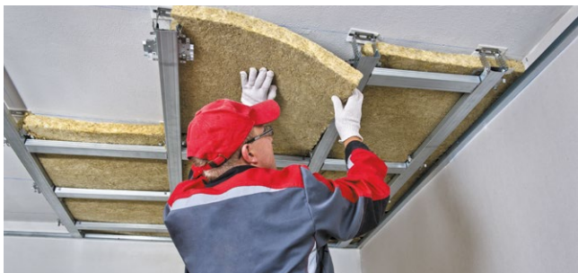
Рис. 5.24. Укладка плит ТЕХНОАКУСТИК
