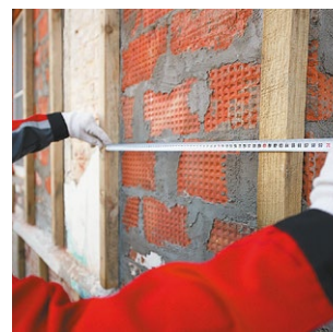
Рис. 7.1. Крепление вертикальных стоек деревянного каркаса
