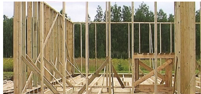
Рис. 7.19. Установка деревянного каркаса
