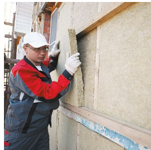
Рис. 7.4. Монтаж теплоизоляционных плит в горизонтальный каркас
