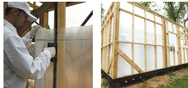
Рис. 7.20. Монтаж пароизоляционной пленки
