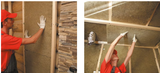
Рис. 6.14. Укладка плит теплоизоляции
