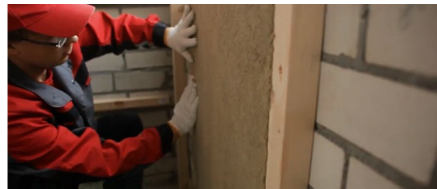
Рис. 7.43. Укладка плит теплоизоляции первого слоя
