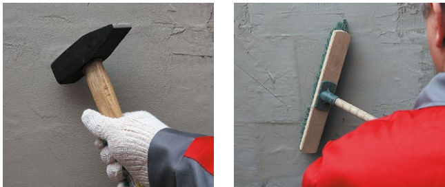
Рис. 6.8. Подготовка помещения к работе
