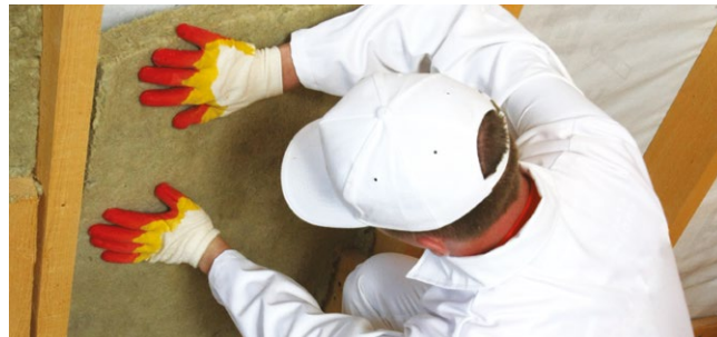
Рис. 4.3.б. Монтаж теплоизоляции враспор между стропилами
