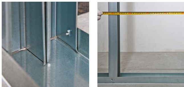
Рис. 6.4. Установка стоечного профиля.
