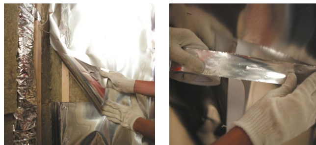
Рис. 6.16. Проклейка стыков пароизоляции
