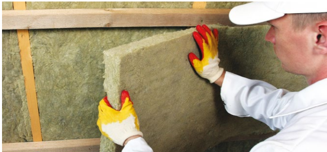
Рис. 4.4.б. Укладка второго слоя теплоизоляции
