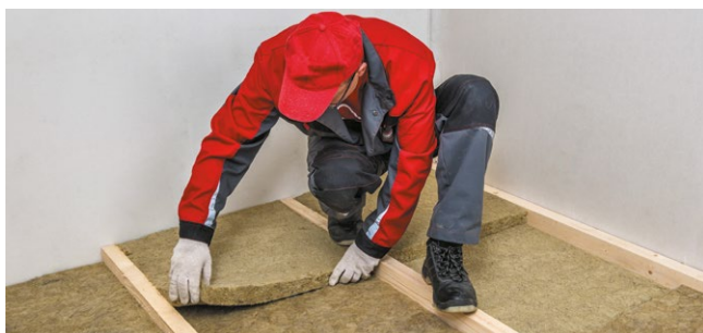
Рис. 5.2. Монтаж теплоизоляции враспор между лагами
