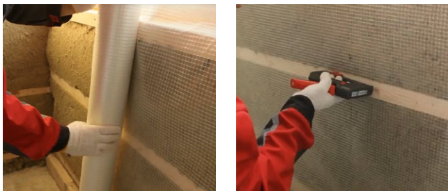
Рис. 7.46. Монтаж пароизоляции
