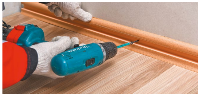
Рис. 5.17. Крепление плинтуса
