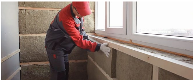
Рис. 7.45. Укладка плит теплоизоляции второго слоя
