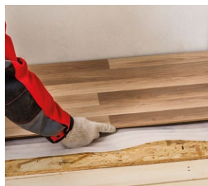
Рис. 5.5. Монтаж чистового покрытия
