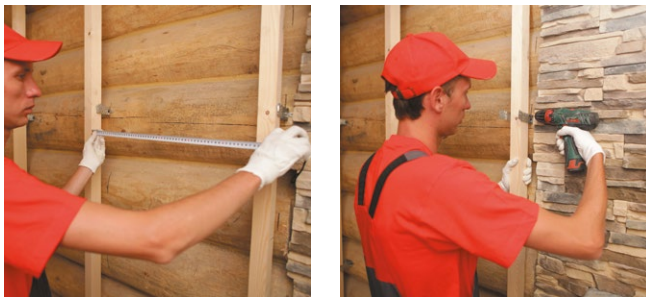
Рис. 6.13. Установка каркаса под теплоизоляцию
