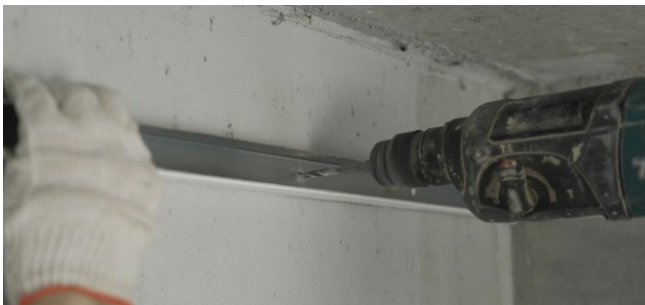
Рис. 5.21. Крепление направляющего профиля
