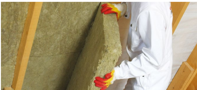
Рис. 4.3.а. Монтаж теплоизоляции враспор между стропилами
