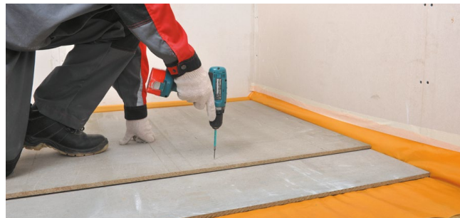
Рис. 5.11. Устройство сборной стяжки
