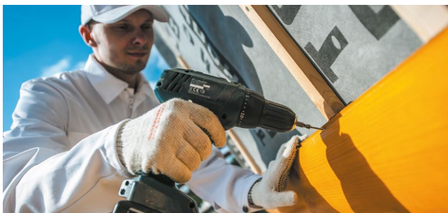
Рис. 7.23.а. Монтаж облицовочного материала
