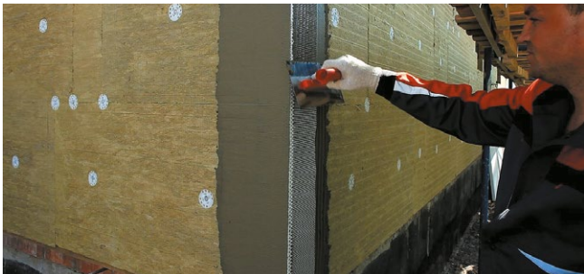
Рис. 7.37. Установка усиливающих профилей на углах здания
