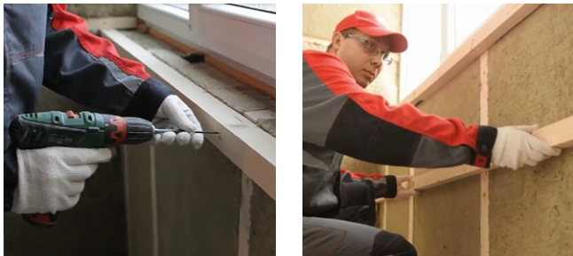
Рис. 7.44. Установка горизонтального каркаса под теплоизоляцию
