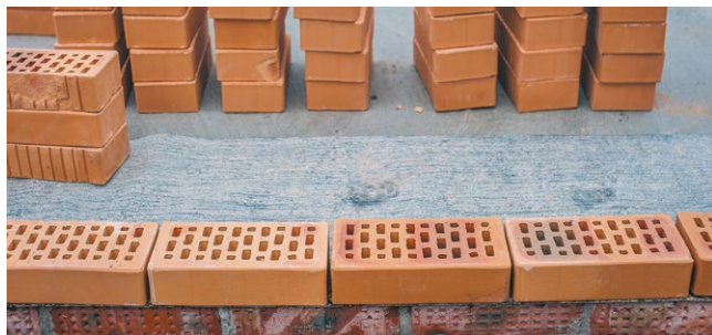
Рис. 7.8. Гидроизоляционная отсечка
