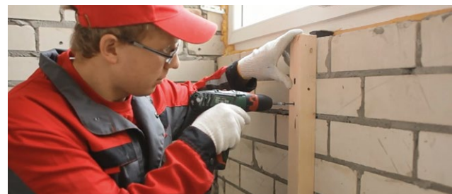
Рис. 7.42. Установка вертикального каркаса под теплоизоляцию
