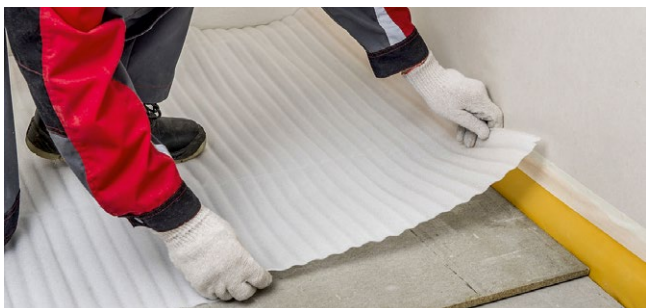
Рис. 5.14. Укладка подложки под финишное покрытие пола
