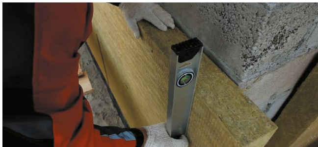
Рис. 7.31. Приклейка плиты тепло-, звукоизоляции к стене
