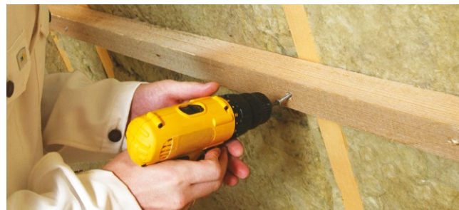
Рис. 4.4.а. Укладка второго слоя теплоизоляции
