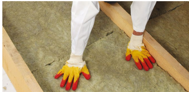
Рис. 4.11. Монтаж теплоизоляции между балками
