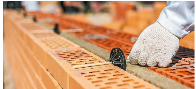
Рис. 7.14. Установка гибких связей
