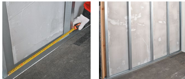
Рис. 6.10. Установка направляющего и стоечного профилей
