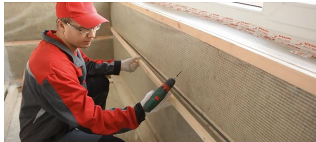
Рис. 7.47. Монтаж контррейки
