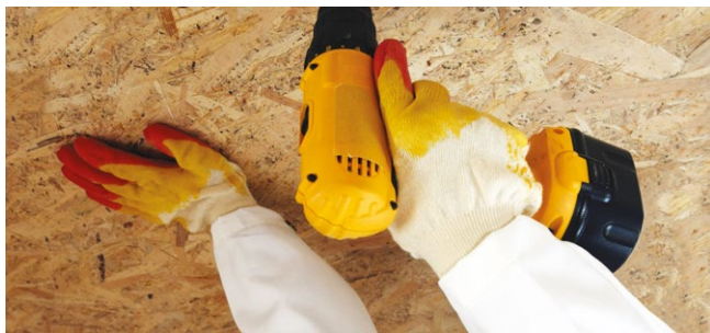
Рис. 4.10. Подшивка потолка листами ОСП
