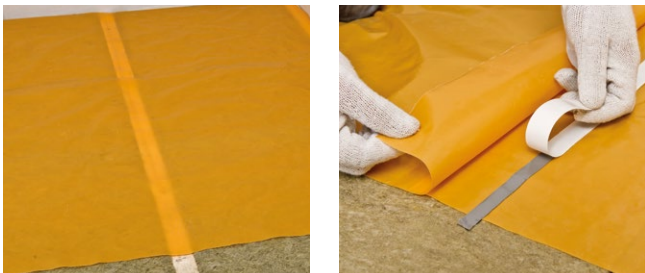
Рис. 5.3. Монтаж и проклейка нахлестов пароизоляционной пленки
