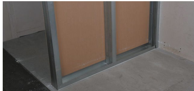
Рис. 6.5. Обшивка первой стороны листом ГКЛ
