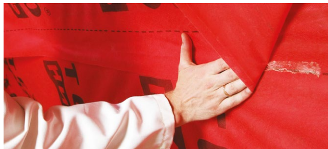
Рис. 4.6. Проклейка стыков пароизоляционной пленки
