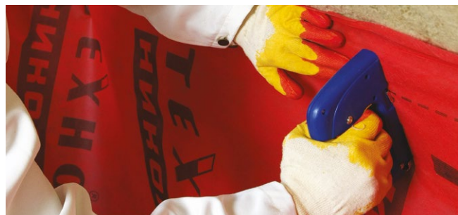
Рис. 4.5. Укладка и фиксация пароизоляционной пленки
