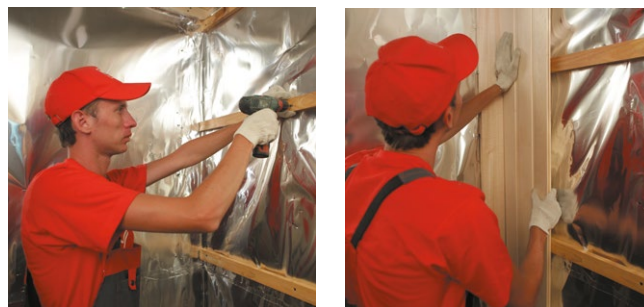
Рис. 6.17. Устройство внутренней обшивки
