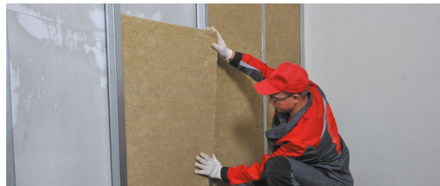
Рис. 6.11. Монтаж тепло-, звукоизоляционных плит
