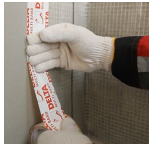
Рис. 7.53. Проклейка примыканий пароизоляции к стенам и окну
