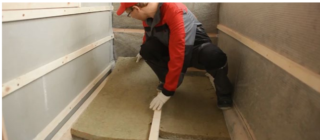
Рис. 7.50. Укладка теплоизоляционных плит
