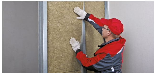
Рис. 6.6. Укладка плит ТЕХНОАКУСТИК
