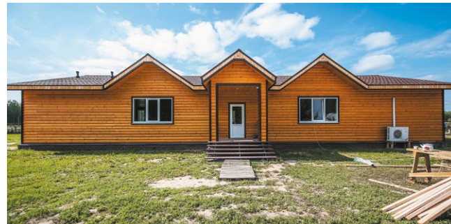
Рис. 7.23.б. Монтаж облицовочного материала
