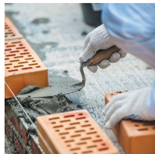
Рис. 7.10. Монтаж внешней версты
