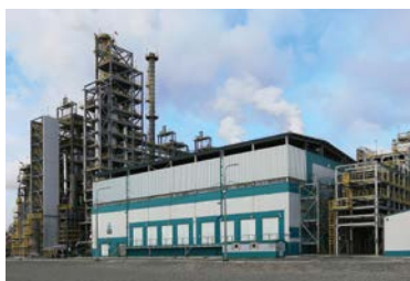
«ЗапСиб-2» («ЗапСибНефтехим»), г. Тобольск, Тюменская обл.
