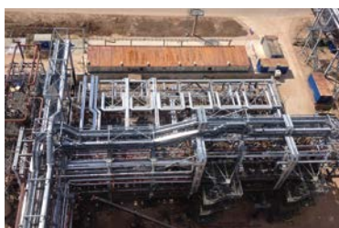
ЛУКОЙЛ-Нижегород-нефтеоргсинтез, г. Кстово, Нижегородская обл.
