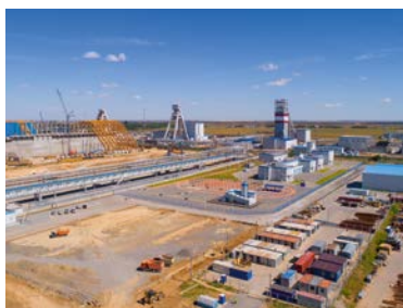
Гремяческий ГОК «ЕвроХим», ж/д станция Гремячая, Волгоградская обл.
