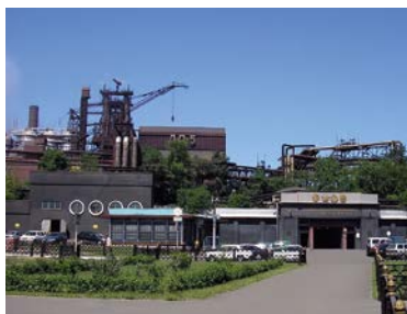
ЕВРАЗ Западно-Сибирский металлургический комбинат, г. Новокузнецк
