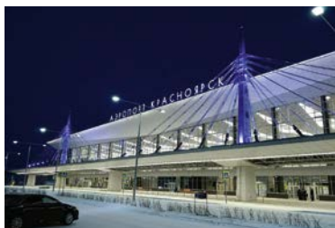
Аэропорт «Емельяново», г. Красноярск
