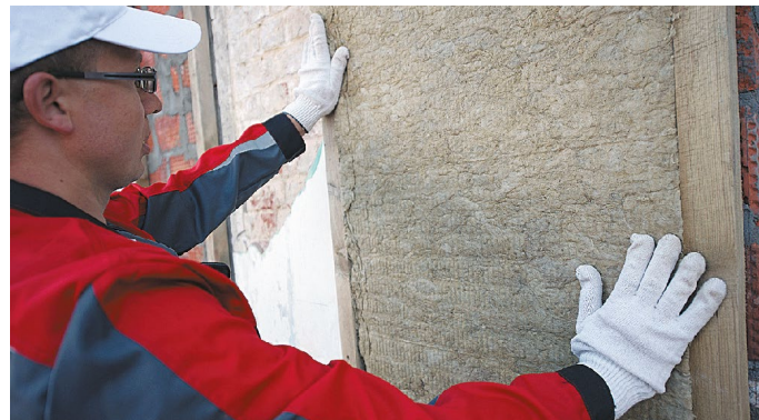
Рис. 2. Монтаж теплоизоляционных плит в вертикальный каркас
