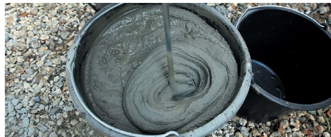
Рис. 25. Замешивание клея для приклейки теплоизоляции
