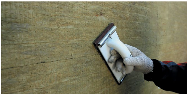
Рис. 32. Шлифовка стыков плит теплоизоляции наждачной бумагой
