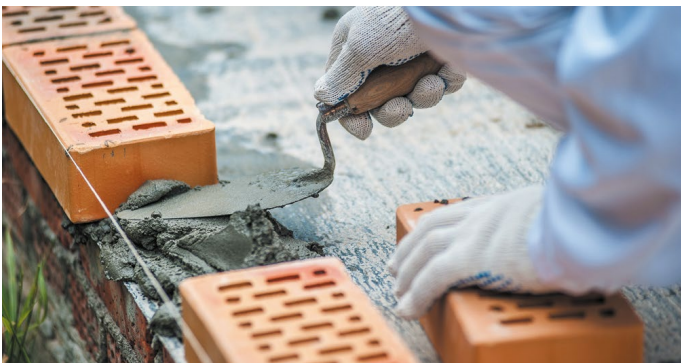
Рис. 9. Монтаж внешней версты
