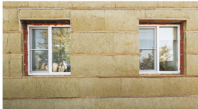
Рис. 4. Монтаж теплоизоляционных плит в горизонтальный каркас
