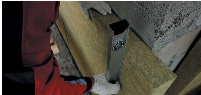
Рис. 29. Приклейка плиты тепло-, звукоизоляции к стене
