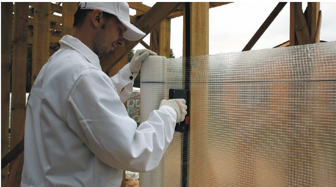
Рис. 19. Монтаж пароизоляционной пленки
