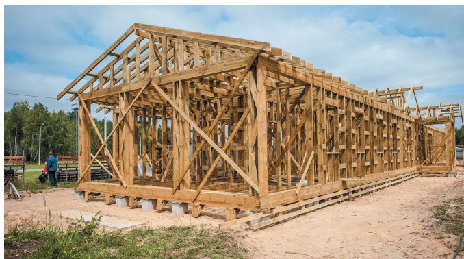
Рис. 18. Установка деревянного каркаса
