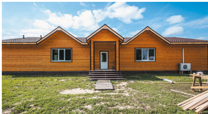
Рис. 22. Монтаж облицовочного материала
