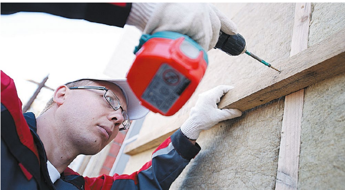
Рис. 3. Установка горизонтального каркаса
