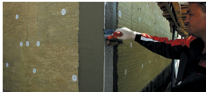
Рис. 35. Установка усиливающих профилей на углах здания
