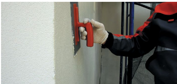
Рис. 39. Нанесение декоративного слоя штукатурки
