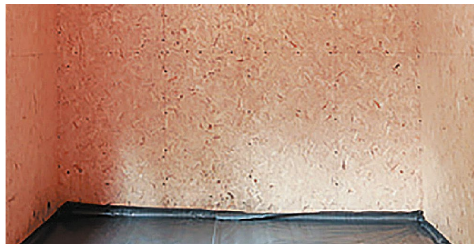
Рис. 23. Обшивка внутренней поверхности стен
