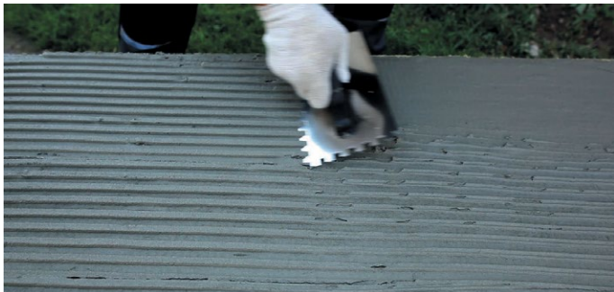
Рис. 26. Нанесение клеевого состава на плиту сплошным методом приклейки
