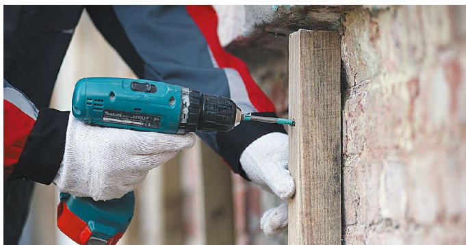
Рис. 1. Крепление вертикальных стоек деревянного каркаса
