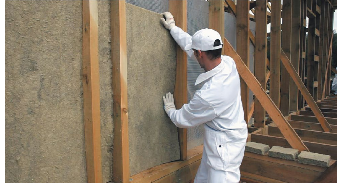
Рис. 20. Монтаж теплоизоляционных плит
